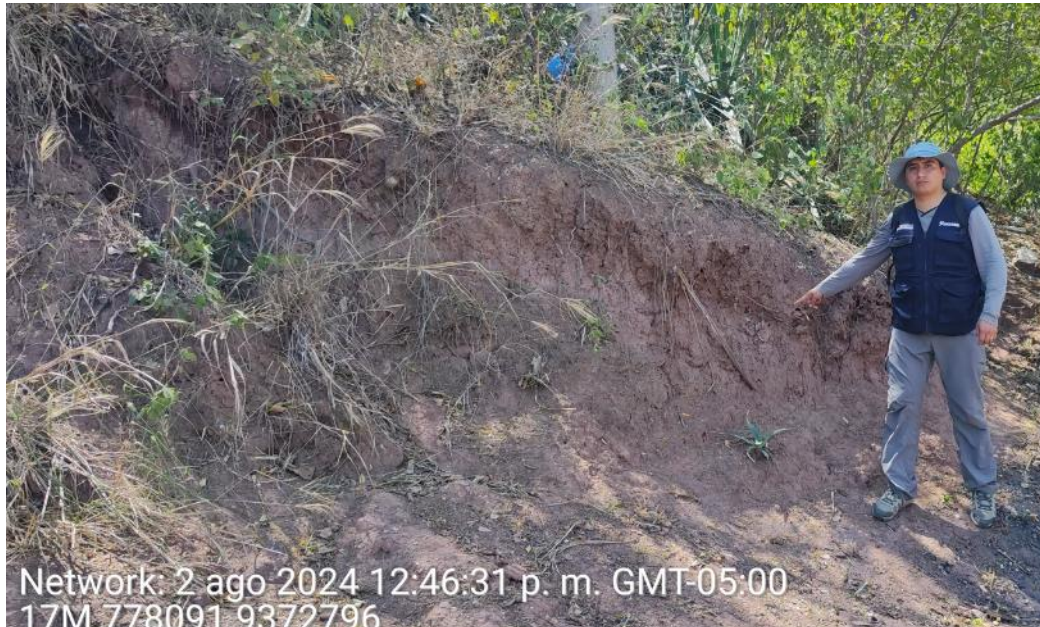
Fotografía 1. Corte de talud donde se aprecia a la Formación El Milagro, muy fracturada y altamente meteorizada.
