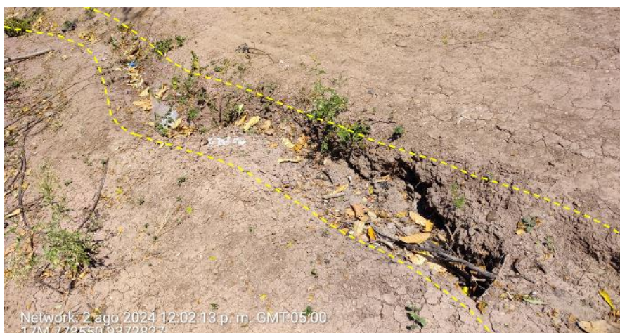
Figura 10. Proceso de erosión por flujos de lodo en las vías de la localidad de Peca Palacios.
