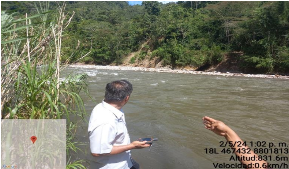
En la columna de fotografías se observa primero : Cauce en épocas de estiaje, tramo donde se propone defensa ribereña tipo gaviones; segundo : Material a descolmatar en cauce de río Paucartambo.
