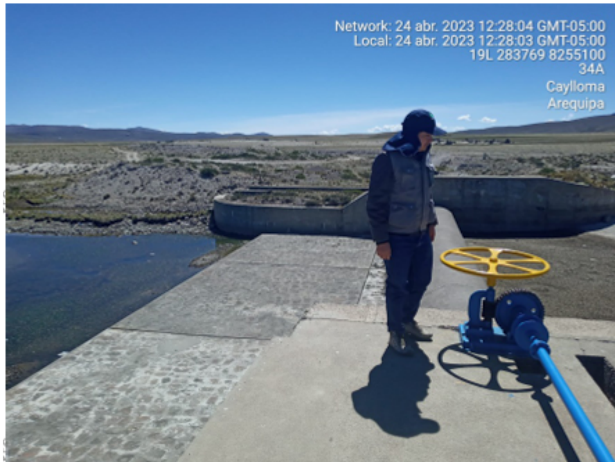
Figura 4. Bocatoma parte de la infraestructura hidráulica
