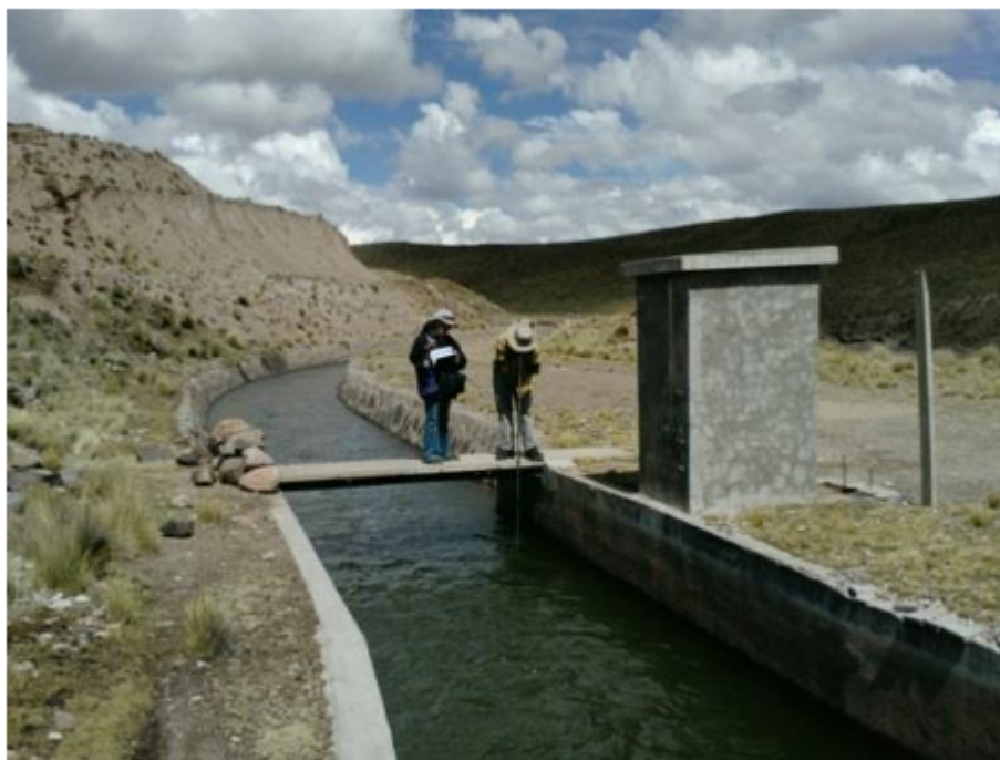
Figura 7. Estación de aforo en tramo Bamputañe -río negro.
