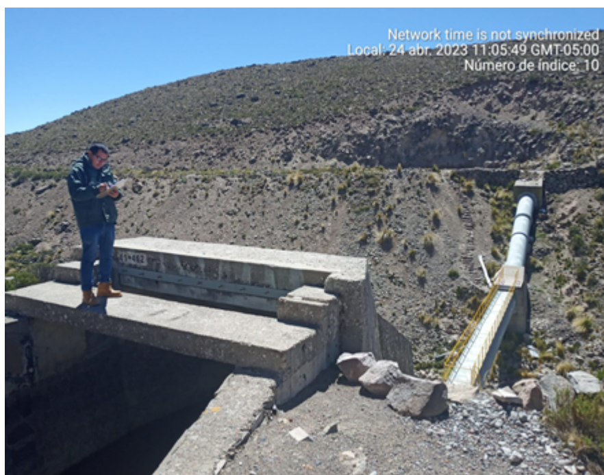
Figura 3. Infraestructura hidraulica – Sifon del canal Pañe Sumbay
