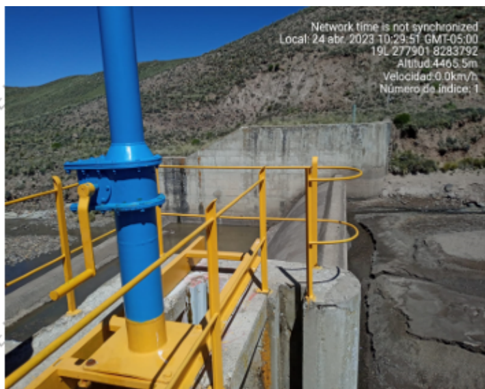
Figura 2. Bocatoma ubicada en la coordenada 277901E 8283792N
