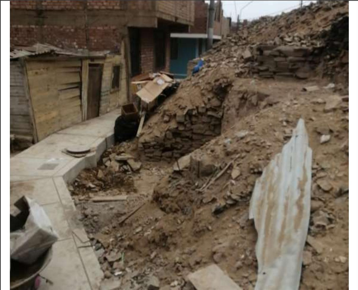
Talud inestable con relleno no controlado que limita con la Mz C.
