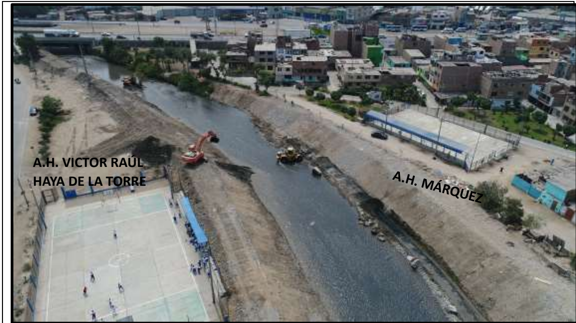
Vista aérea del cauce del río Chillón, se verifican que se están ejecutando trabajos de descolmatación y encauzamiento.
