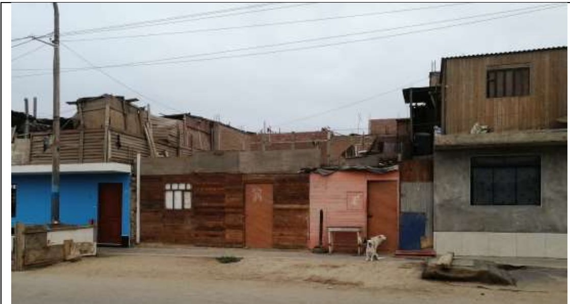
Viviendas de material precario de madera lotes 11 A, 11B, 11C de la Mz U, altamente vulnerables a inundación fluvial por desborde del río Chillón
