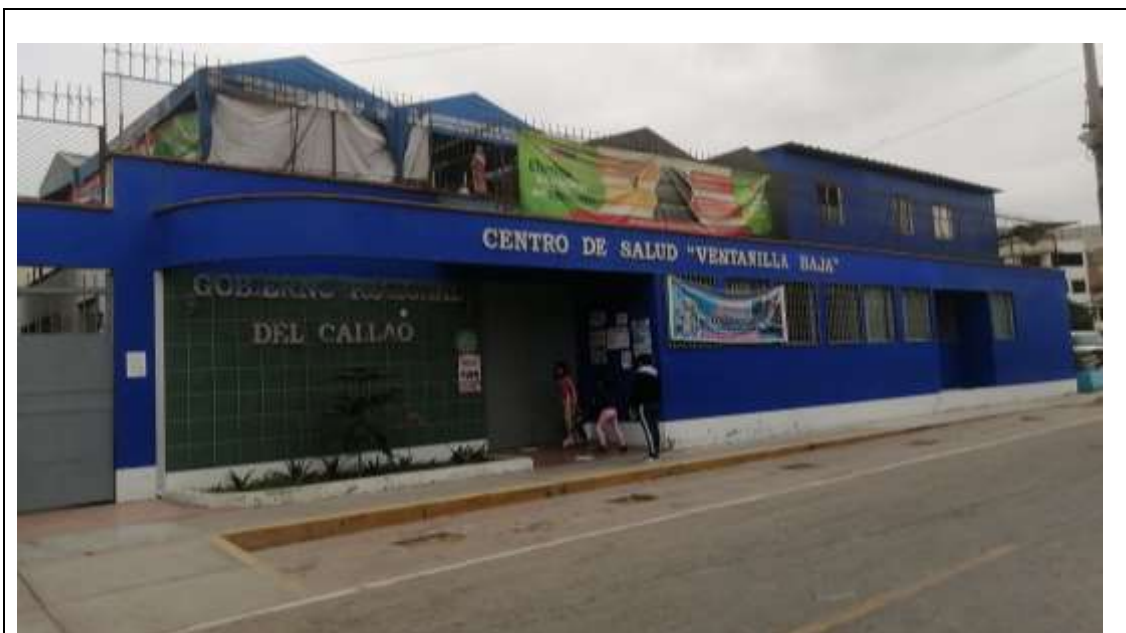
Centro de Salud "Ventanilla Baja" que da servicio a los pobladores
