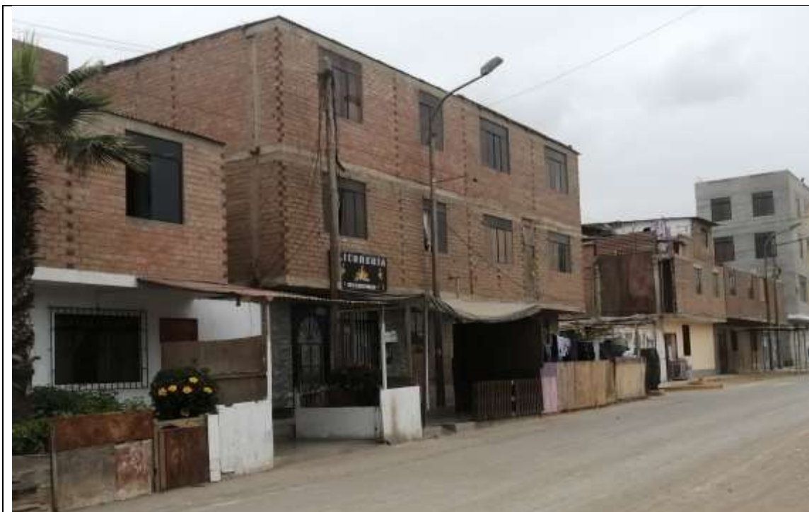
Viviendas de las Mz. W y V con muros de ladrillo tienen todos los servicios básicos y son colindantes con el río Chillón.
