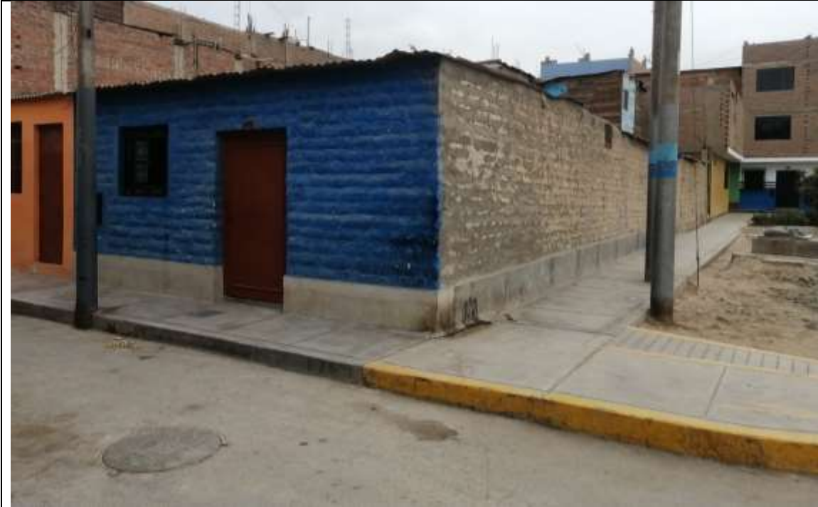
Mz T lote 12 vivienda de adobe cercano a la ribera del río Chillón.
