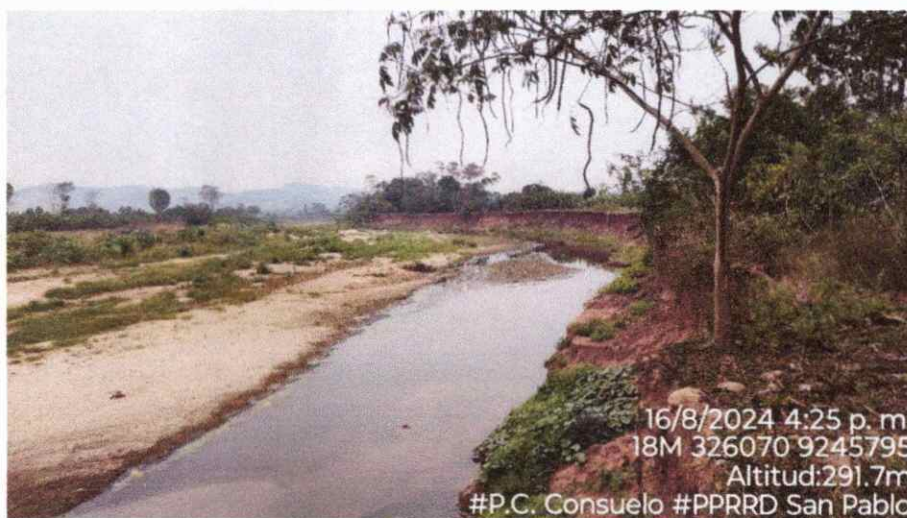
Imagen 01. Erosión fluvial en el CCPP de Consuelo.
