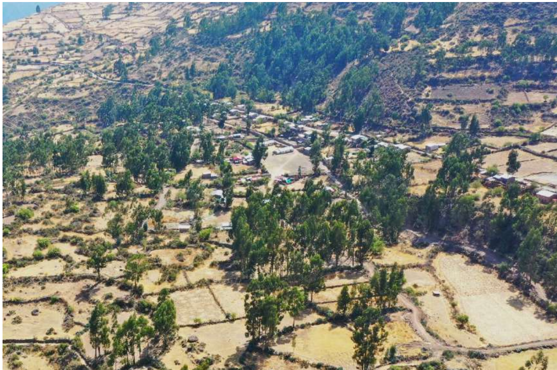
Fotografía 13. Vista panorámica de las viviendas de San José de Ccachccara asentada sobre el cuerpo de deslizamiento inactivo latente.
