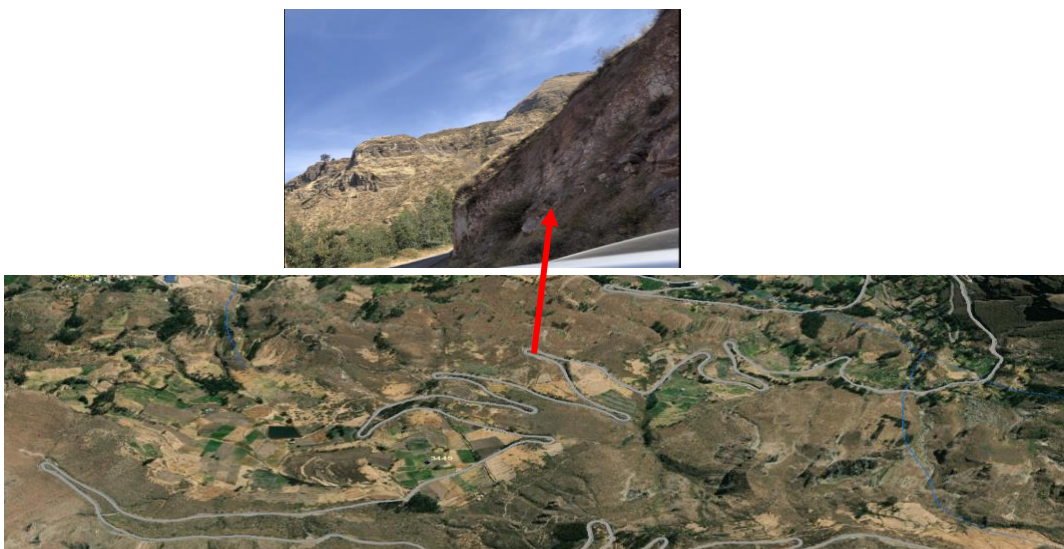
Figura Nº 14: Sector crítico – Laderas escarpadas por corte de carretera
