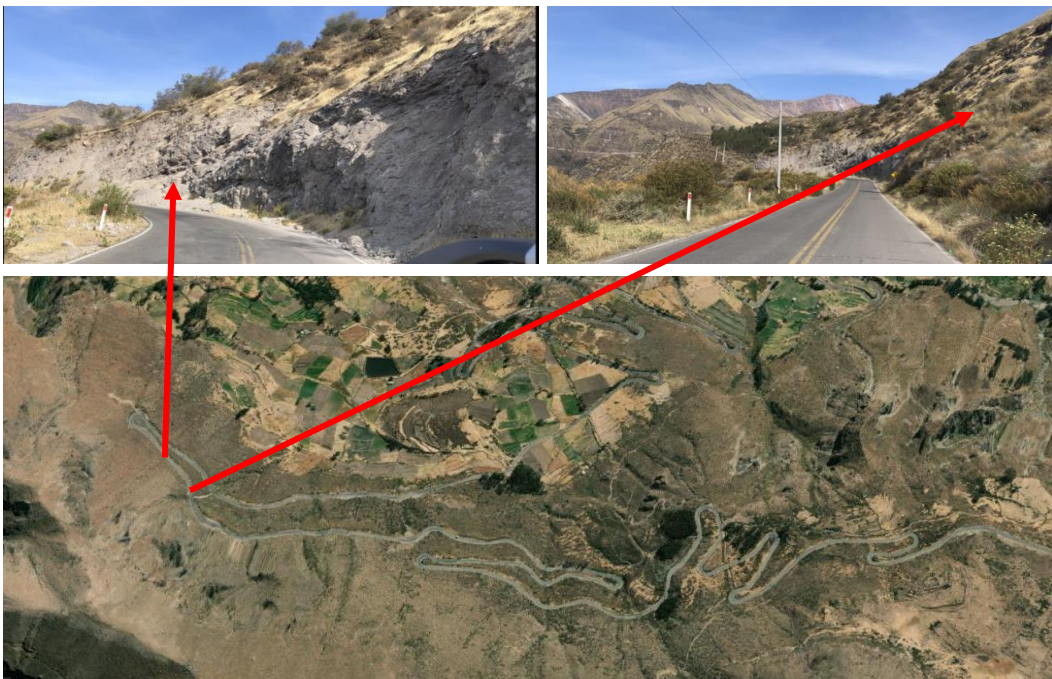
Figura Nº 12: Sector crítico – Pendientes que generan derrumbes
