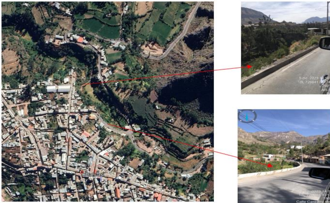
Figura Nº 23: Sector crítico – quebrada Corira y Chacaylla
