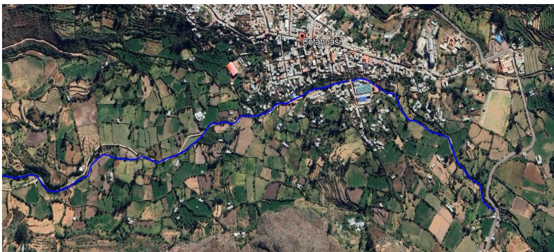
Figura Nº 24: Sector crítico – quebrada Piro
