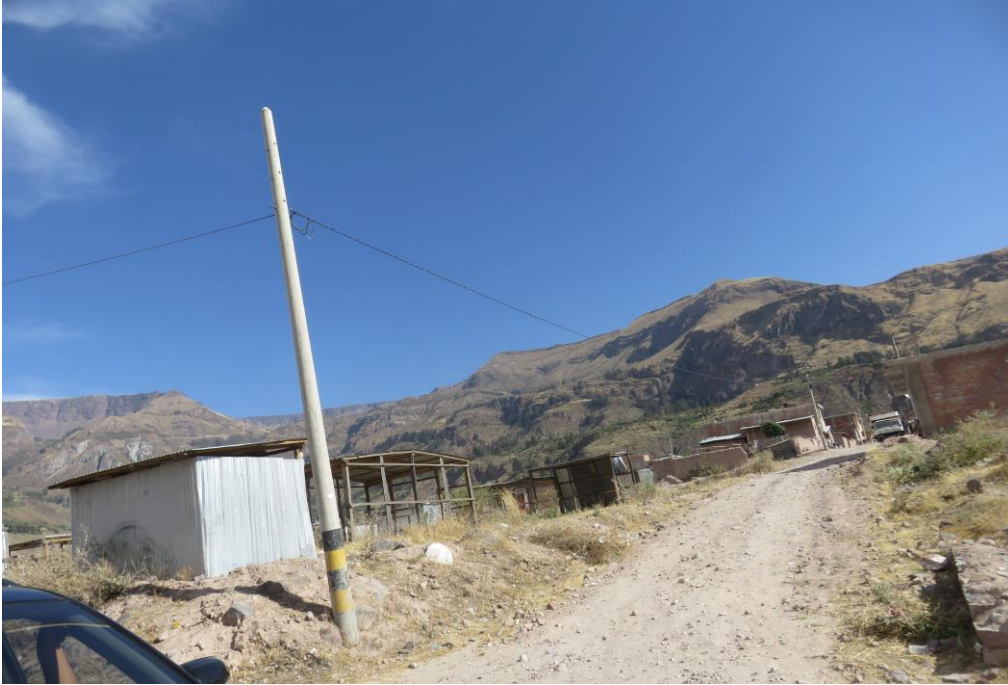
40. Imagen del acceso a algunas viviendas ubicadas en la tercera etapa de Aymaña
