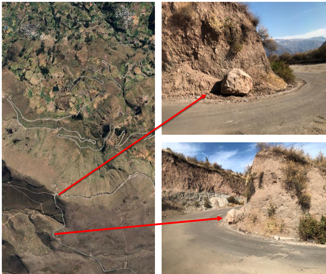
Figura N° 10: Sector crítico – El cruce distrito de Cotahuasi y distrito Toro
