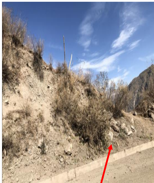
Figura Nº 15: Sector crítico – Depósitos coluvión-aluvial
