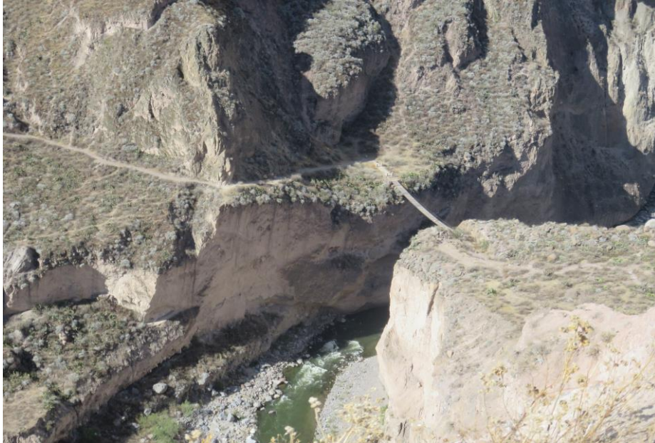
42. Vista del puente Chaime
