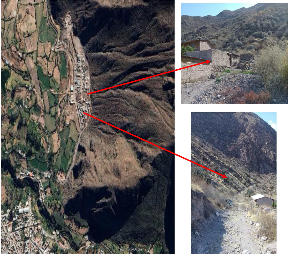
Figura Nº 22: Sector crítico- localidad de Chacaylla
