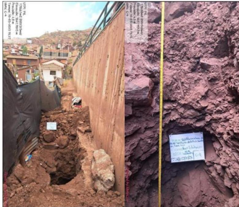
Foto 8: Depositos coluviales en la APV. Alto San Martín
