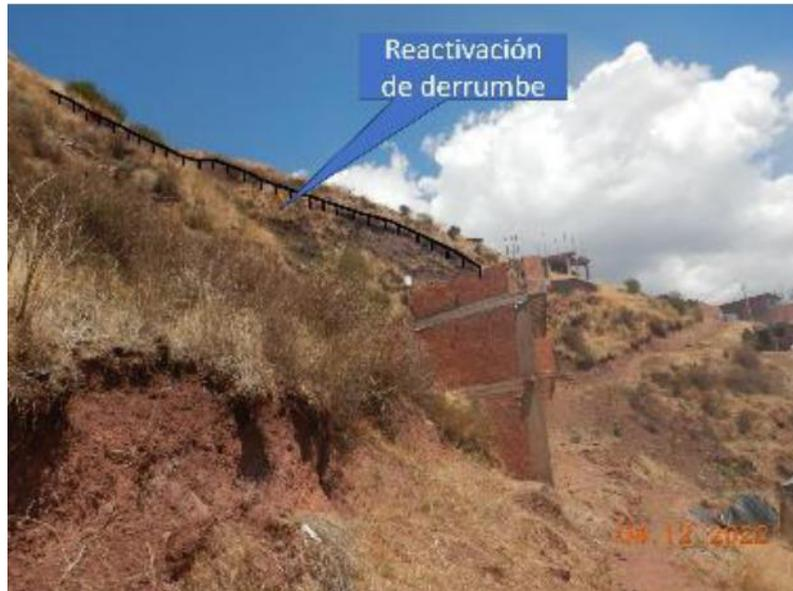
**Foto 11: Reactivación de derrumbe al sur oeste parte alta de la APV Alto San Martín – INGEMMET – Informe Técnico N° A7451**
