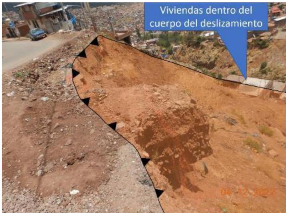
Foto 15: Escarpa e deslizamiento activo en margen de la vía Cusco al Botadero de Hakira, viviendas 03 viviendas expuestas al deslizamiento – INGEMMET – Informe N° A7451
