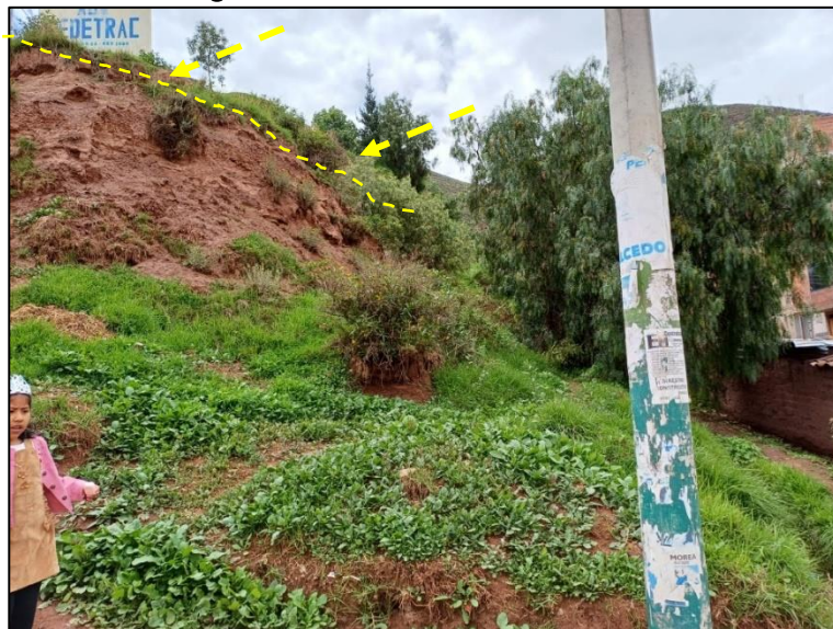
Fotografía 12. Terraza alta en el flanco derecho
