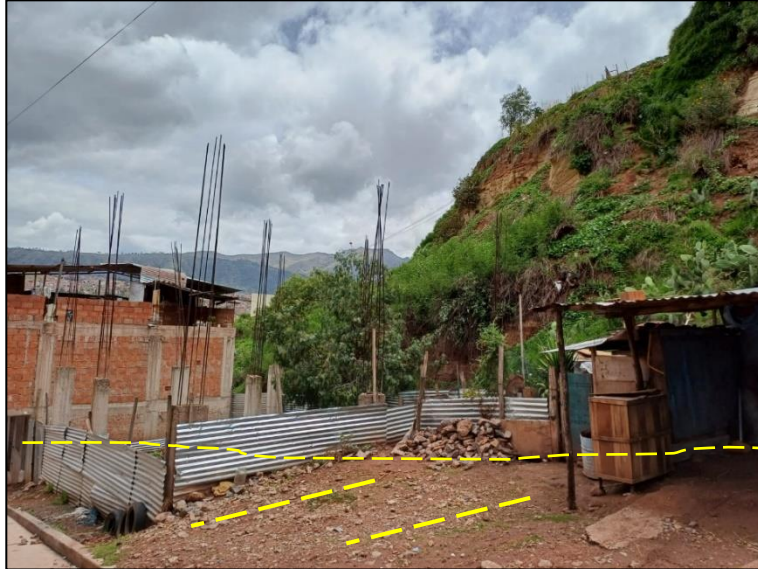
Fotografía 13. Terraza alta en el flanco derecho
