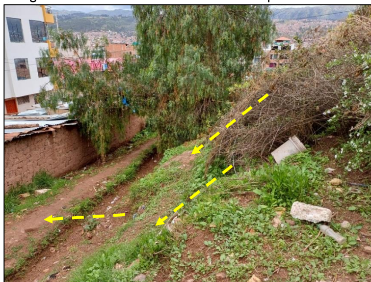
Fotografía 8. Pendientes moderadamente empinadas a inclinada
