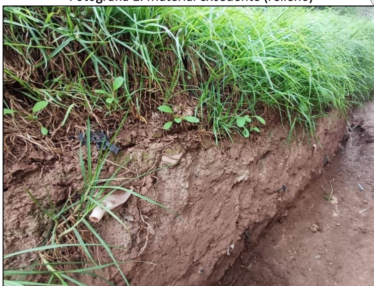
Fotografía 1. Material excedente (relleno)
