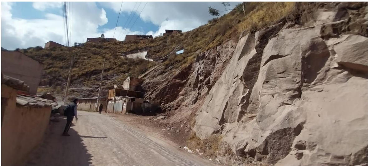
Foto 5 Afloramientos de secuencias de areniscas marrones, sector norte de la APV. Unión San Martín al pie de la vía San Martín, se observa el grado de compactación y escaso fracturamiento de las rocas, que le dan resistencia a erosiones.
