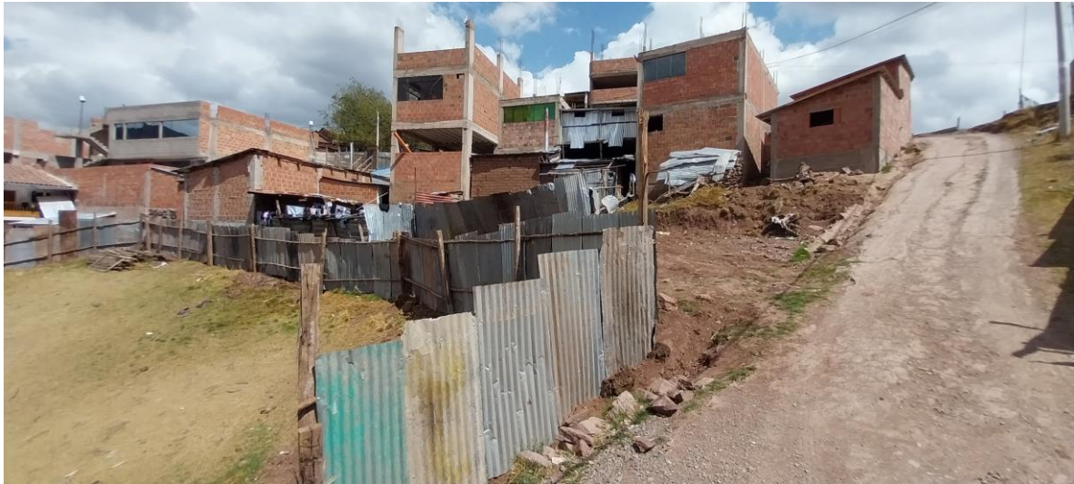
Foto 25 Tipo de viviendas construidos de ladrillos en estructura de concreto armado, manzanas h, k de la apv. Unión san martín
