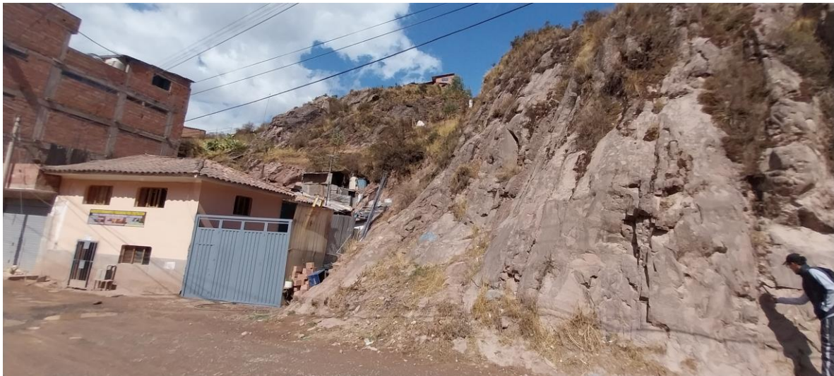
Foto 18 Edificaciones construidas en la parte alta sobre afloramientos rocosos, sector este de la APV. Unión San Martín
