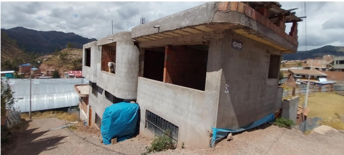
Foto 24 Tipo de viviendas construidos de ladrillos en estructura de concreto armado, manzana I de la APV. Unión San Martín
