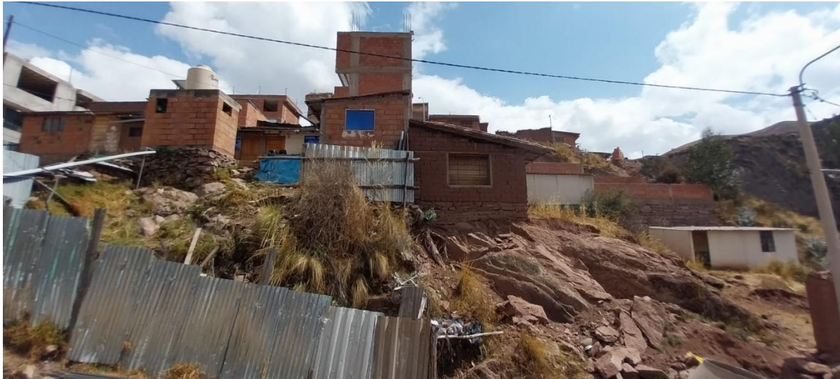
Foto 4 Afloramientos de secuencias de areniscas marrones, sector este de la APV. Unión San Martín. Se puede observar además edificaciones sobre este tipo de litología.
