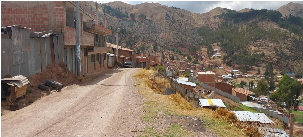
Foto 26 Tipo de viviendas construidos de ladrillos en estructura de concreto armado, manzana e de la apv. Unión san martín
