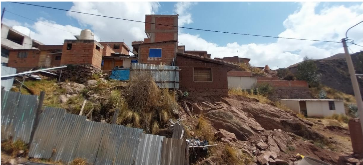
Foto 23 Viviendas edificadas sobre afloramientos de rocas manzana II de la APV. Unión San Martín
