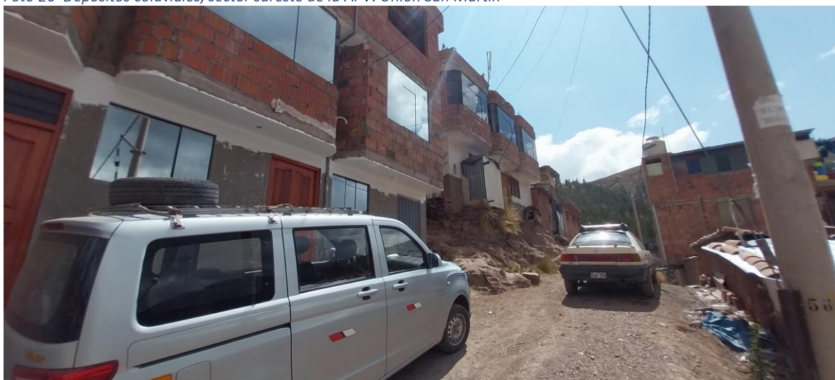
Foto 21 Viviendas edificadas sobre afloramientos de rocas manzana j de la APV. Unión San Martín
