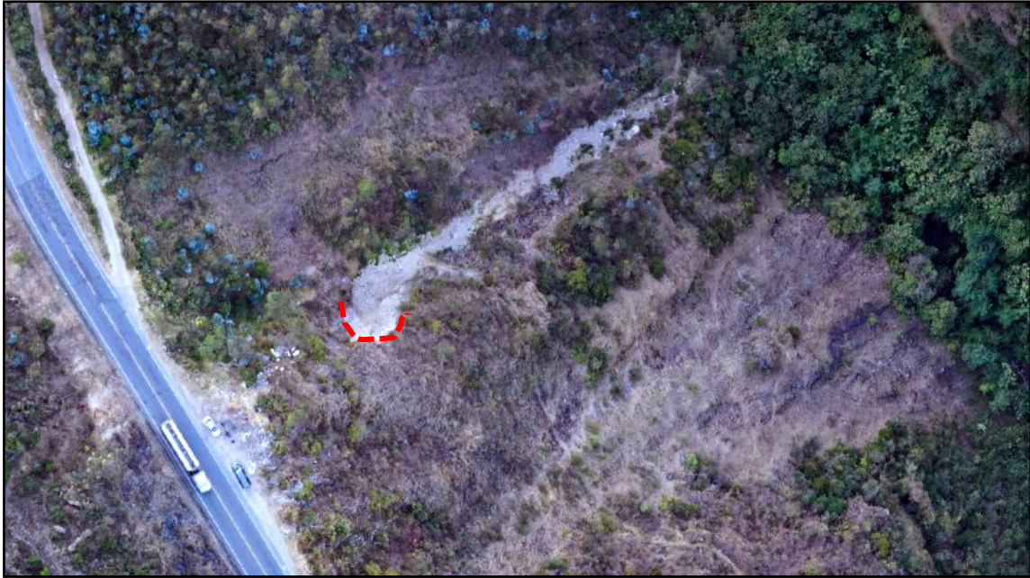
Figura 16. Derrumbe en la parte baja de la vía Abancay – Cusco. Coordenadas UTM E 732591, N 8494106 Z18.
