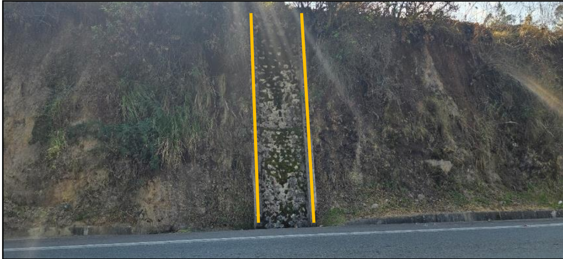
Figura 11. Sistema de evacuación de aguas de escorrentía de la vía Abancay – Cusco en el punto con coordenadas UTM E 732514, N 8494642 Z18.
