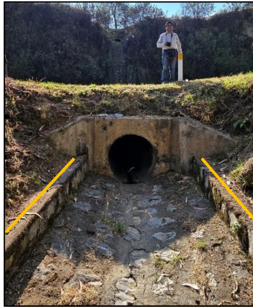
Figura 13. Sistema de evacuación de aguas de escorrentía, de la vía Abancay – Cusco, en el punto con coordenadas UTM E 732542, N 8494630 Z18.
