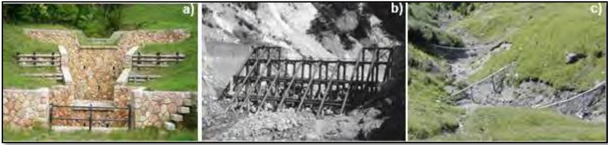
Figura 18. Presas tipo SABO de sedimentación escalonada para controlar la fuerza destructiva de los huaicos, a) de control; b) tipo rejilla; c) barras flexibles, (Vilches, 2021)
