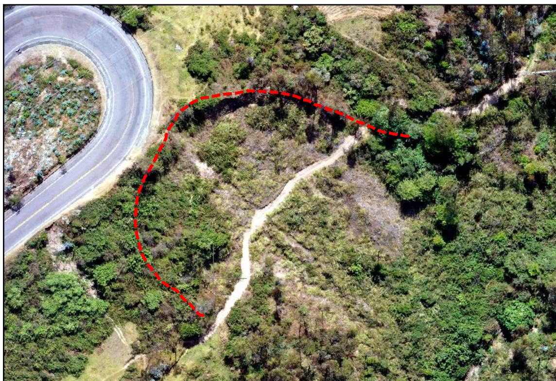
Figura 15. Deslizamiento rotacional en la parte baja de la vía Abancay – Cusco. Coordenadas UTM E 732807, N 8495233 Z18.
