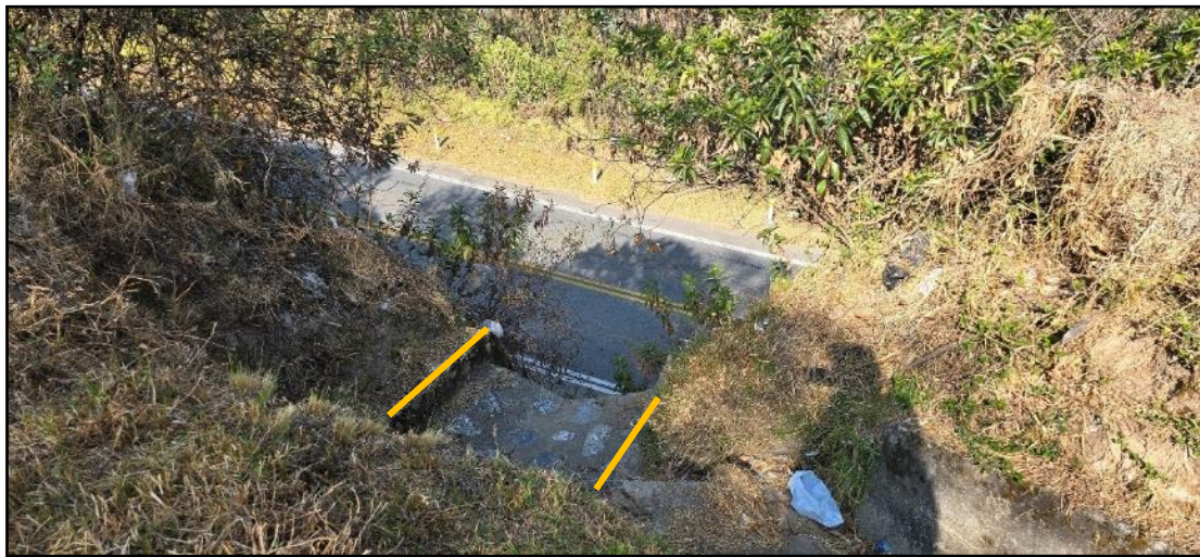
Figura 12. Sistema de evacuación de aguas de escorrentía, de la vía Abancay – Cusco, en el punto con coordenadas UTM E 732531, N 8494636 Z18.
