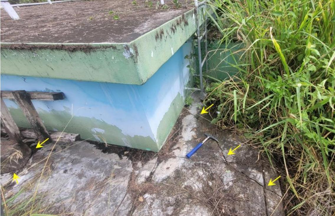
**Figura 10.** Agrietamientos (indicado por flechas amarillas), en el reservorio de captación de agua en la localidad de Huillarán.
