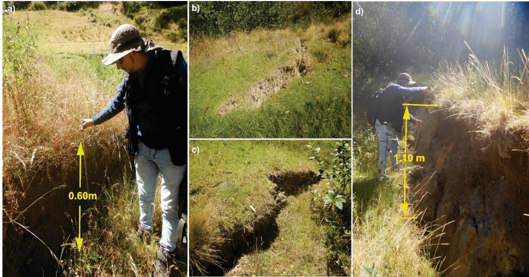
Figura 13. Saltos de 0.20 m a 1.10 m, con direcciones de noroeste-noreste, de hasta 14 m de longitud.
