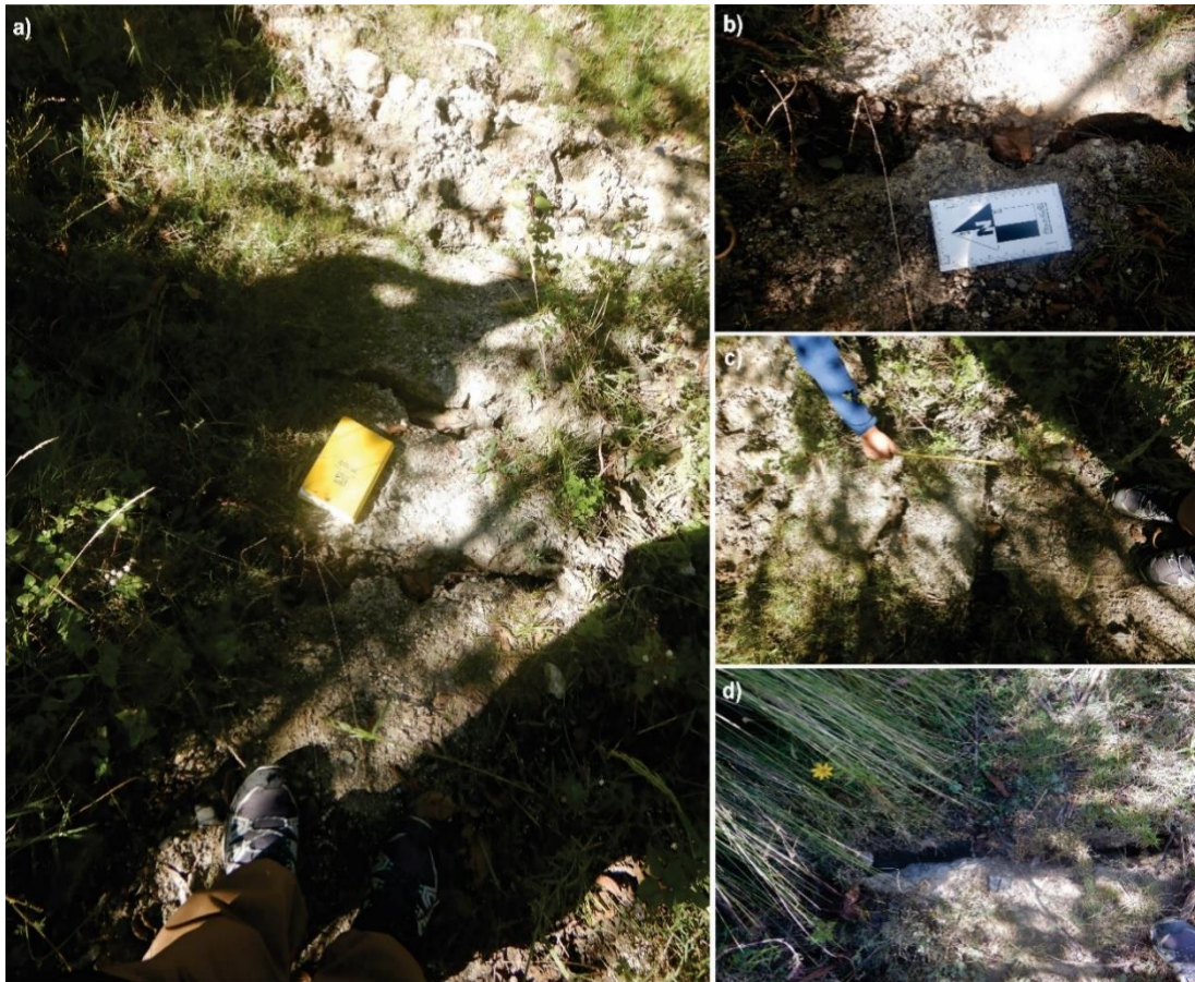
Figura 14. Filtraciones de aguas subterráneas, que saturan el suelo.
