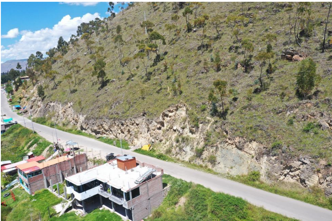
Fotografía 02. Derrumbes en la ladera este de la lomada en rocas volcano sedimentarias, Coordenadas WGS 84, 18s, X: 444501 & Y: 8702026.
