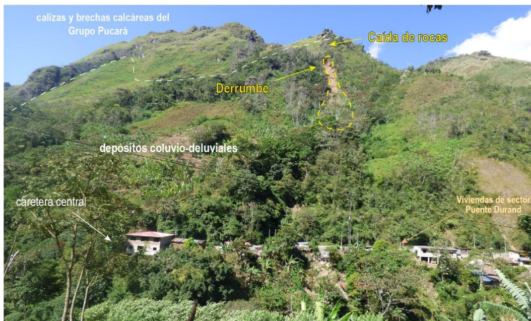
Figura 24. Peligros geológicos identificados en el sector Puente Durand. Vista panorámica mirando al sureste.
