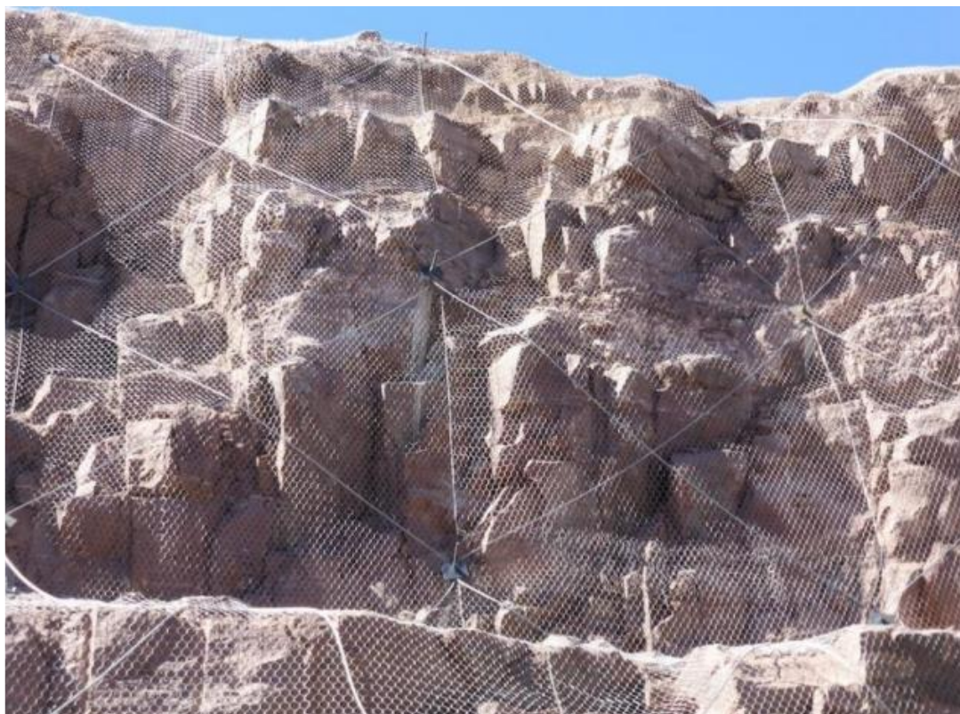
Figura 34. Ejemplo de implementación de mallas ancladas para el control de caída de rocas o bloques rocosos.
