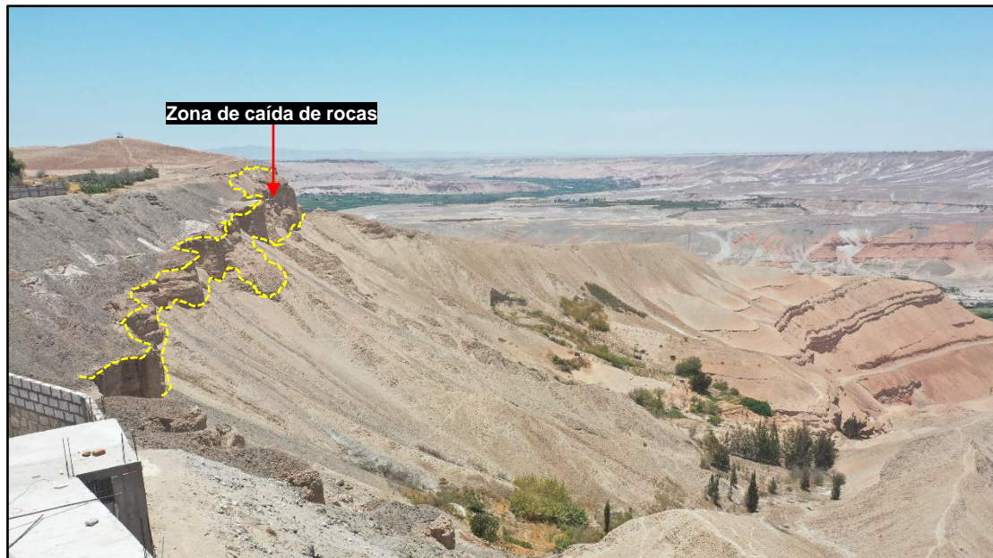
Figura 7. Zona de desprendimiento de rocas en el sector Socabon
