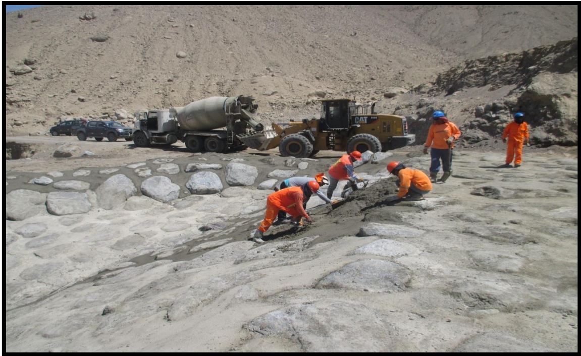
EMBOQUILLADO DE CONCRETO EN EL DIQUE N° 3
