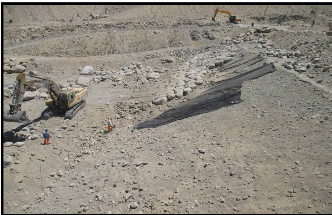
INSTALACION DE GEOTEXTIL DIQUE N°2
