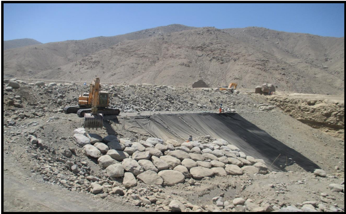
SUMINISTRO E INSTALACION DE GEOTEXTIL Y ACOMODO DE ROCA EN TALUD
