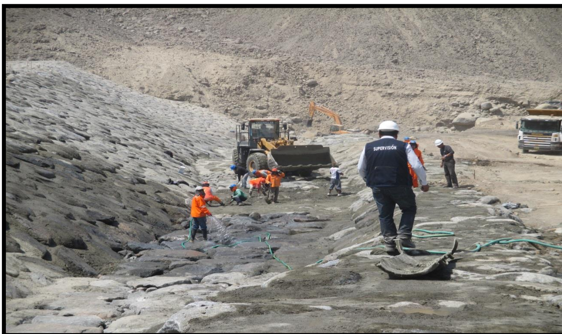
LA SUPERVISION VERIFICANDO EL EMBOQUILLADO DE CONCRETO
