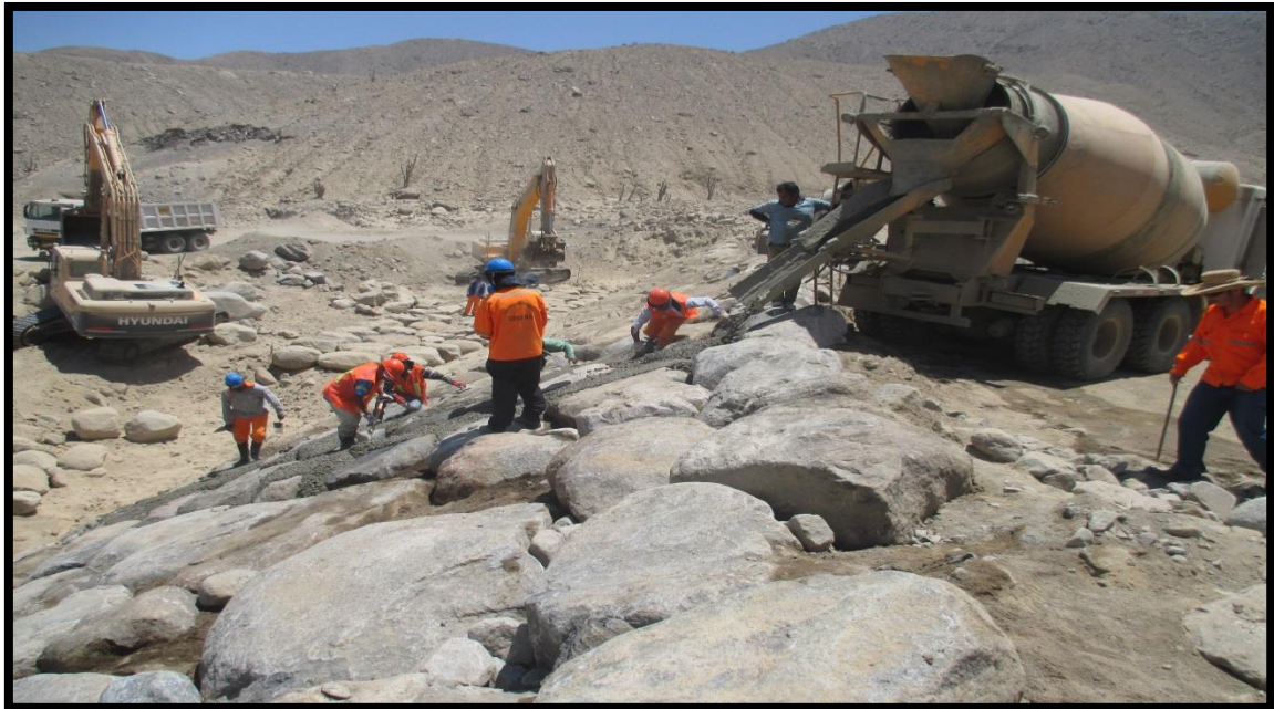
EMBOQUILLADO DE CONCRETO
