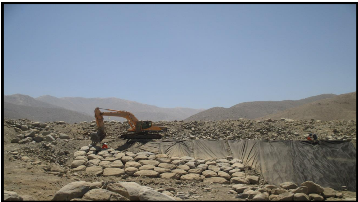
SUMINISTRO E INSTALACION DE GEOTEXTIL Y ACOMODO DE ROCA EN TALUD
