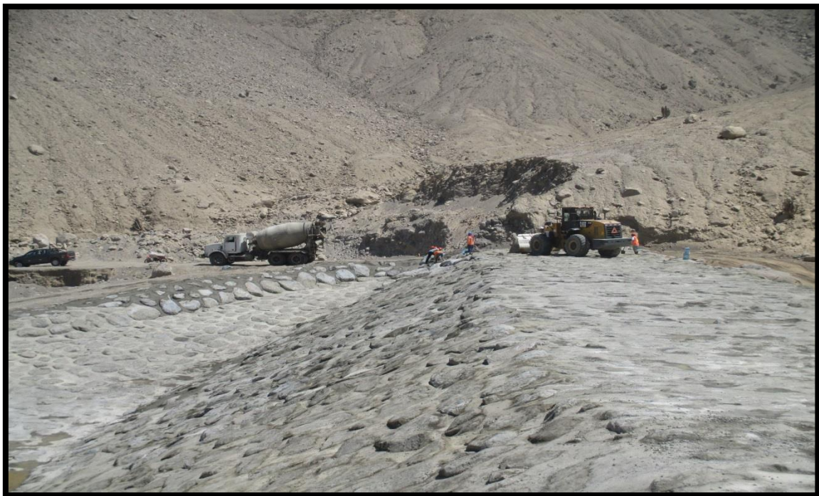
EMBOQUILLADO DE CONCRETO EN EL DIQUE N° 3
