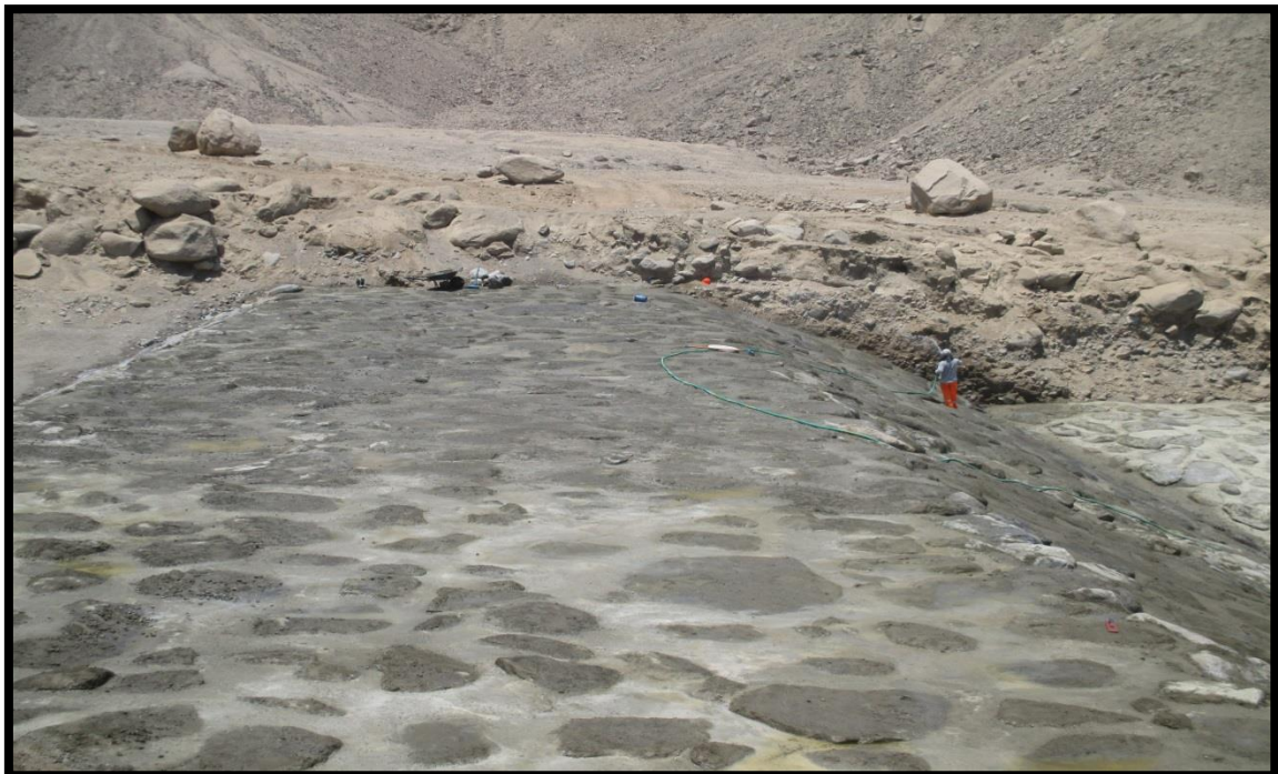
EMBOQUILLADO DE CONCRETO
