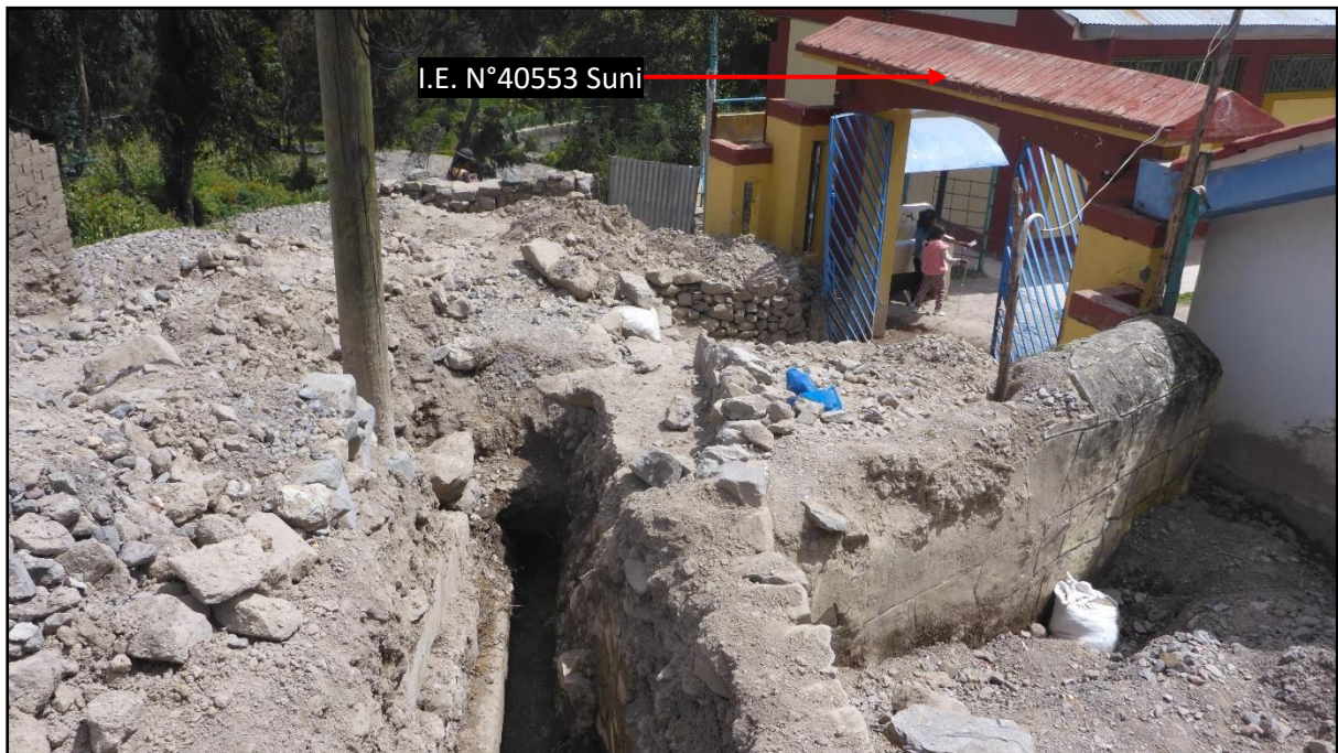
Figura 13. Afectación de viviendas e infraestructura ocasionada por el flujo de detrito del 19 de febrero, como la I.E. N°40553 Suni.
