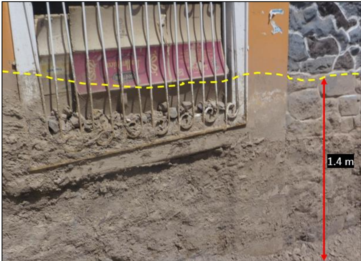
Figura 12. Huella del flujo de detritos del 19 de febrero que alcanzó una altura de 1.40 m.
