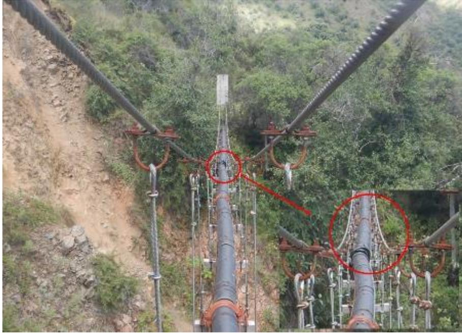
**Figura 2:** Se aprecia el segundo derrumbe D2 que afectó al puente colgante para agua de regadío, con arreglos en la tubería por rajaduras.
