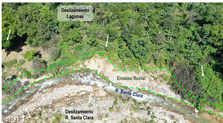
Figura 19. Parte baja del deslizamiento Lagunas, donde se evidencia un deslizamiento al frente que está controlando el curso del río Santa Clara.
