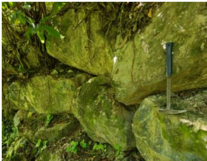
Figura 6. Muro con rocas creado para depositar los materiales antropogénicos en la parte baja de la plataforma de uso múltiple. Ubicación: E: 736787, N: 9317997
