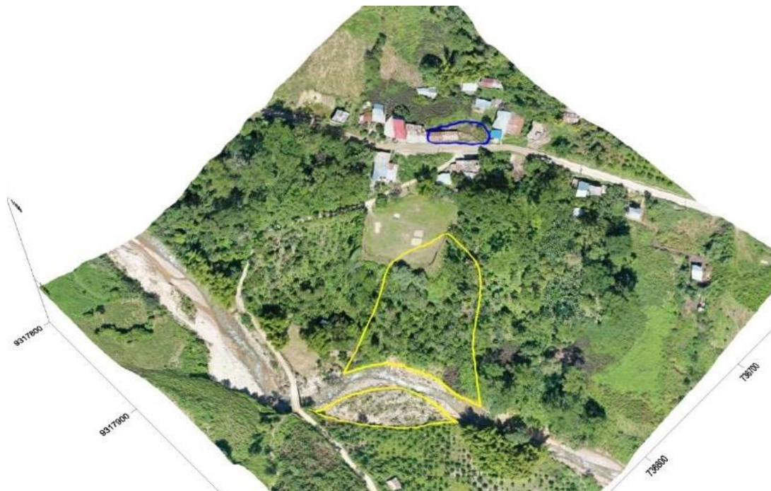
Figura 11. Vista de la localidad de Lagunas, los movimientos en masa están delimitados en línea amarilla y el área con hundimiento en línea azul.
