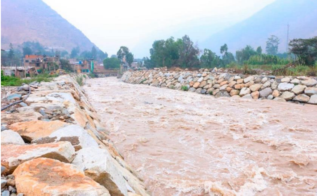
Figura 21. Ejemplo de defensa ribereña con roca al volteo.
