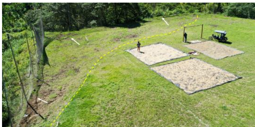
Figura 12. Las líneas amarillas muestran la escarpa principal del deslizamiento rotacional ubicado en la plataforma multiusos de la localidad de Lagunas.
