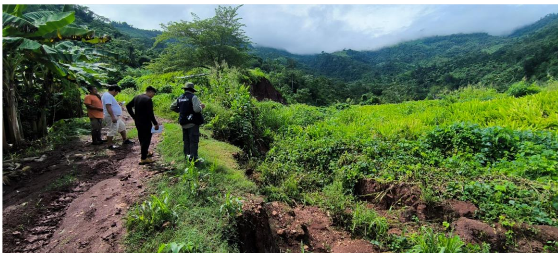
Fotografía 7. Muestra el escarpe principal superior del deslizamiento Da 2, además de las grietas tensionales ubicadas debajo de ella.
