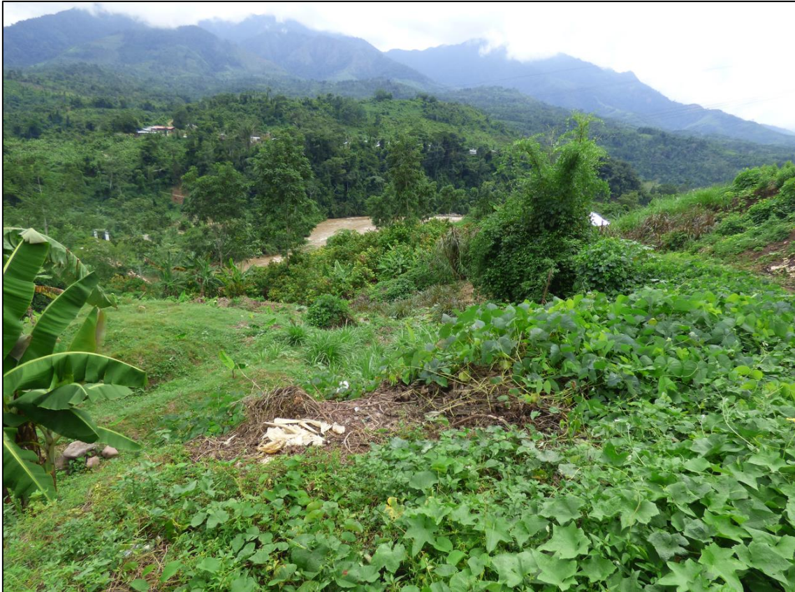
Fotografía 10. Muestra evidencias de inestabilidad en la parte baja de la ladera hasta el río Pangoa, en zonas de plantación de plátanos.
