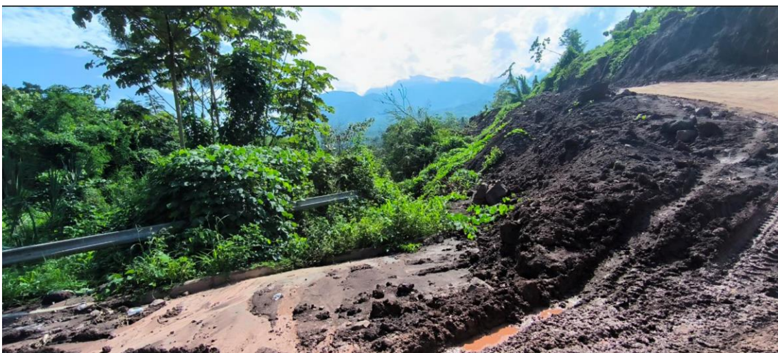
Fotografía 5. Muestra como la primera actividad del deslizamiento afecta 150m de la carretera de acceso.
