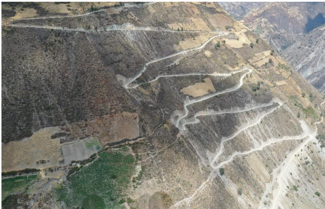
Fotografía 5. Cortes de talud para el desarrollo de vías de comunicación local.
