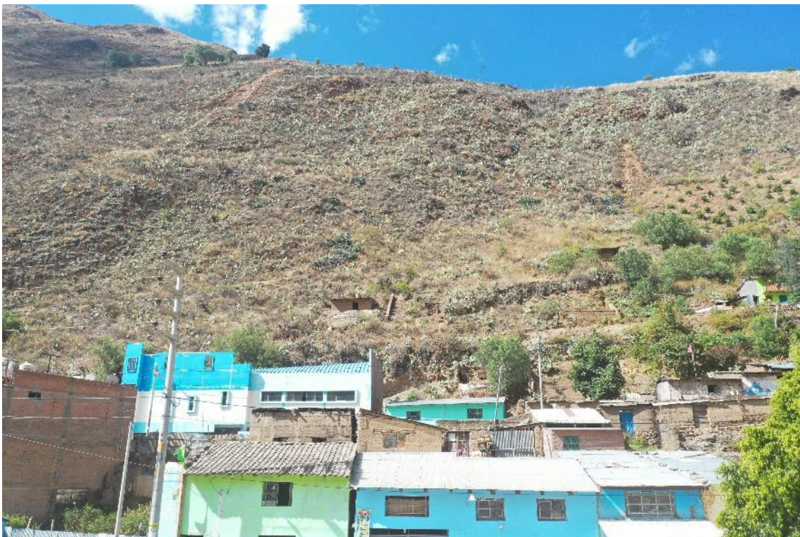
Fotografía 11. Viviendas ubicadas muy cerca de la ladera, las cuales se encuentran expuestas al peligro por desprendimientos de rocas.
