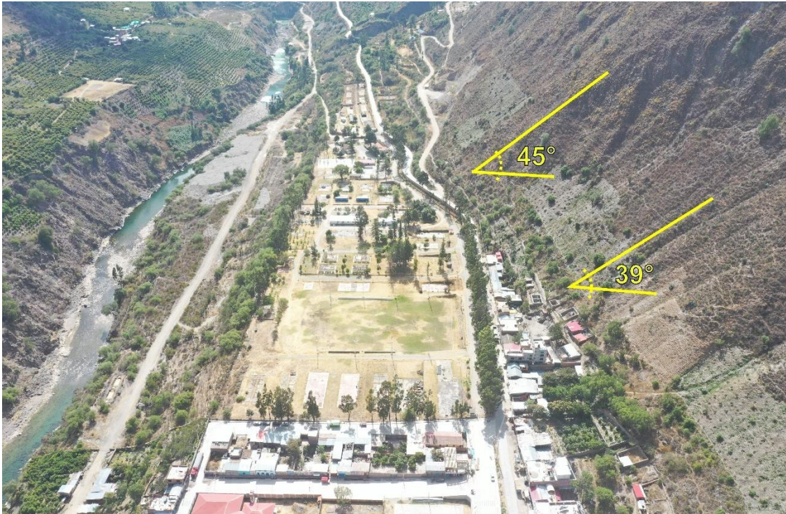
Figura 7. Vista de la inclinación de las laderas colindantes a la localidad de Quichuas (margen izquierdo del río Mantaro), mostrando pendiente muy fuerte a muy escarpadas ( 25^\circ - >45^\circ ).
