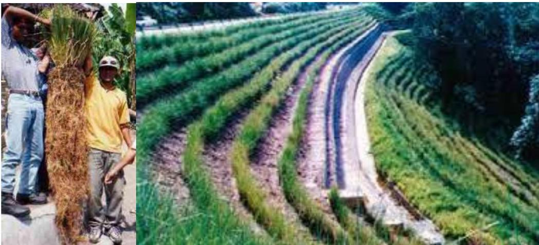
**Fotografía 4.** Ejemplo de bioingeniería con arbusto (vetiver) en taludes de materiales
