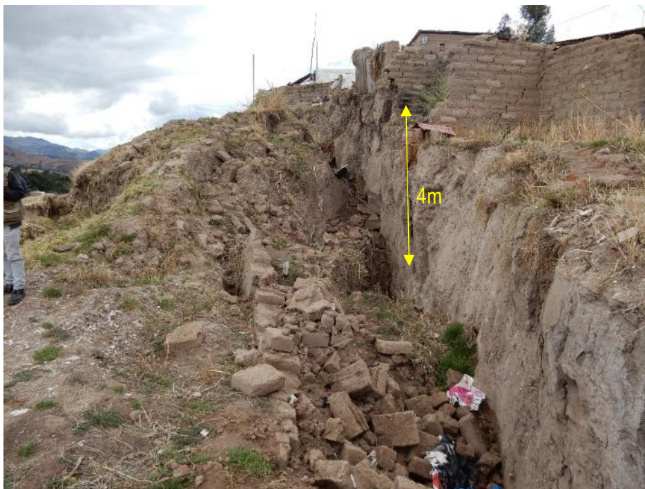
Figura 13: Aspectos del movimiento empezó hace 8 años, donde se aprecia los escombros de casas destruidas.
