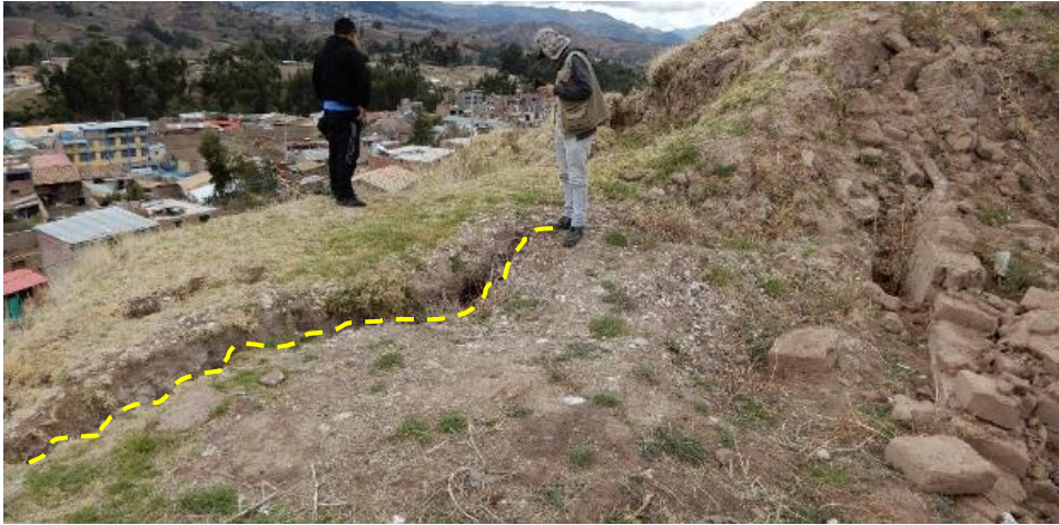
Figura 14: Grieta dentro del cuerpo del desplazamiento activo.
