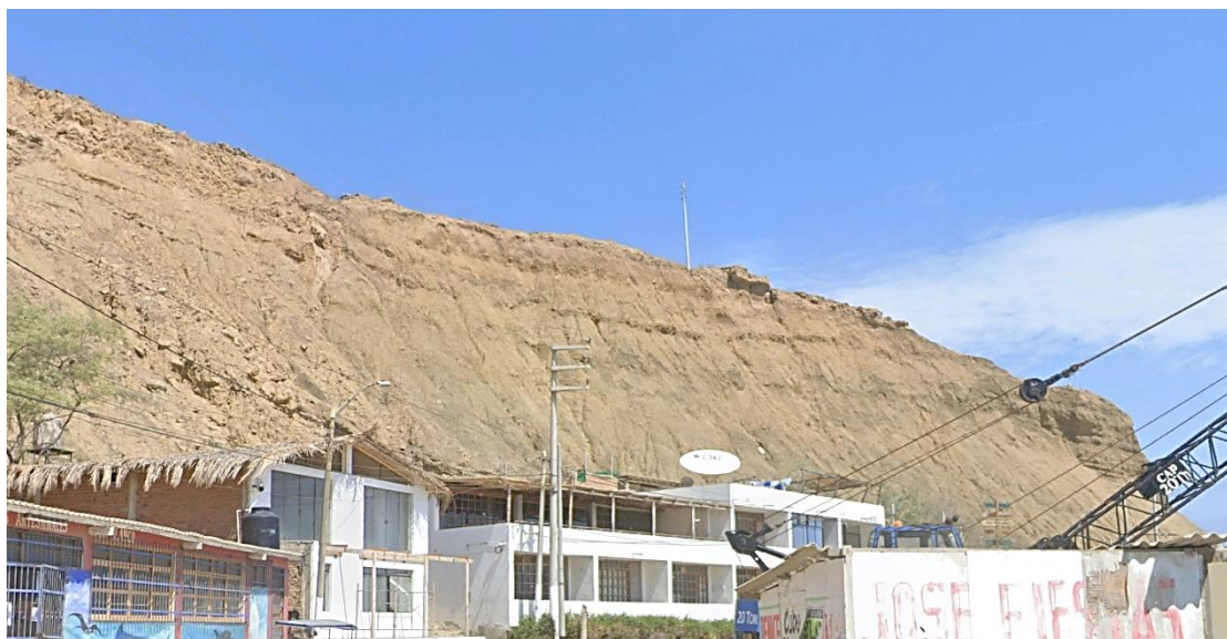
Figura 21. Cárcava en la parte alta del talud, límite entre las colinas y lomadas y la zona de playa en el caserío Cabo Blanco.
