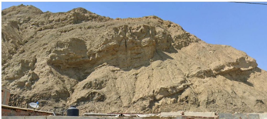
Figura 17. Afloramientos de areniscas que se desprenden en bloques, que pueden afectar viviendas.
