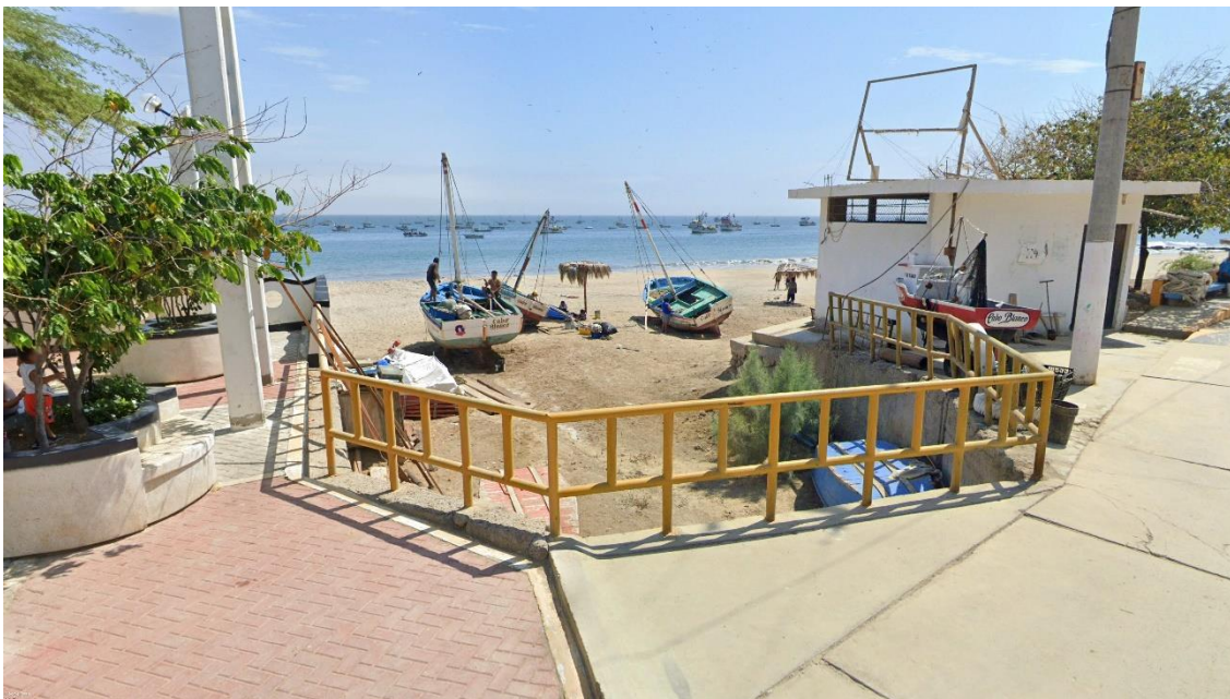
Figura 19. Cauce de quebrada Cabo Blanco 2 con referencia a la I.E.I. 142, donde se activan flujo de detritos y lodos (vista aguas abajo).
