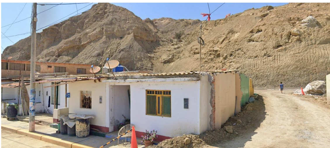
Figura 23. Viviendas afectadas por flujos de lodo y caídas de bloques.
