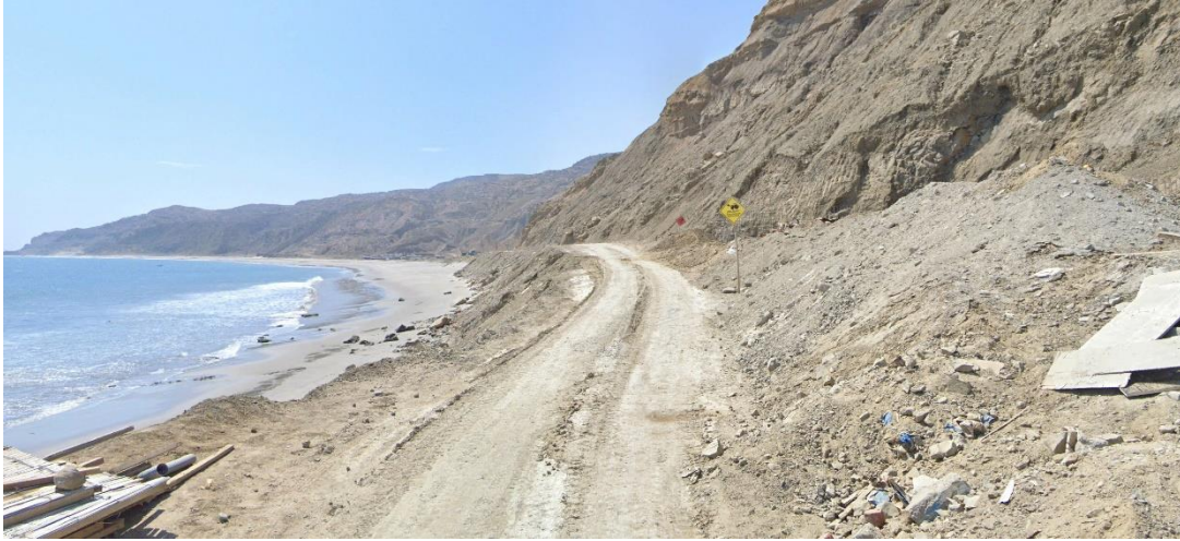
Figura 25. Trocha carrozable del caserío Caleta Cabo Blanco hacia El Ñuro.
