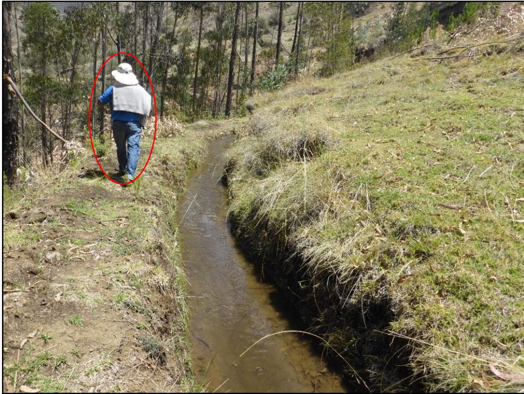
Figura 11. Canal de agua sin revestimiento.
