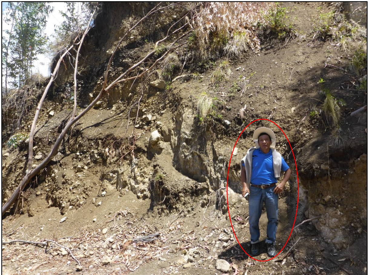
Figura 12. Material suelto y ligeramente humedecido.
