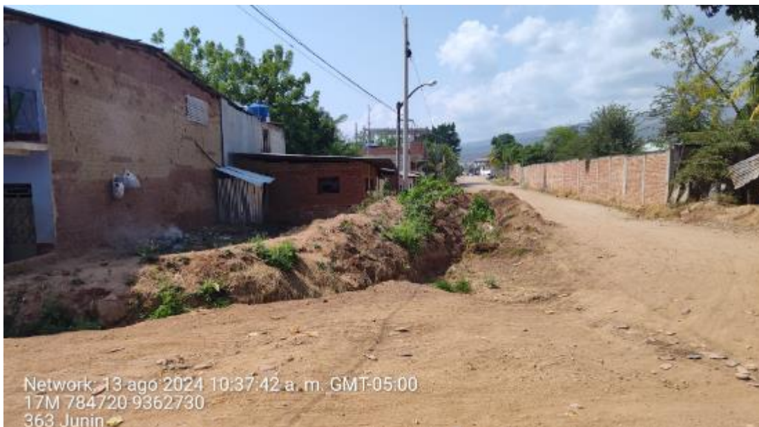
Fotografía 5. Acequias urbanas sin adecuado mantenimiento que son colmatadas por flujos de detritos en el Jr. Junín del sector San Luis.
