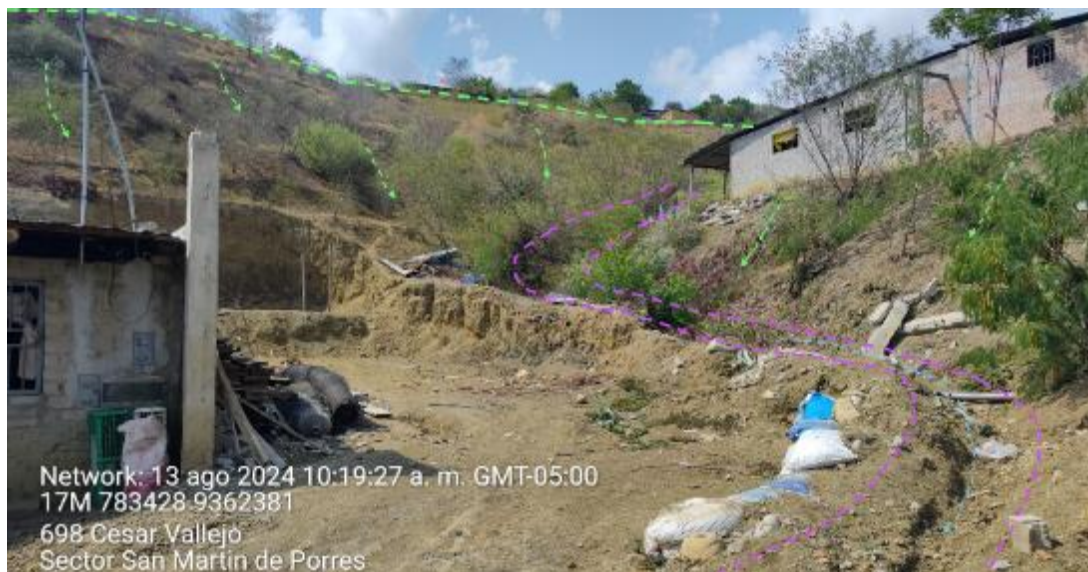
Figura 15. Quebrada sin canalizar que afecta al Jr. Cesar Vallejo del sector San Martín de Porres, se delimita la zona de flujo de detritos (en violeta) y de erosión de laderas (en verde).
