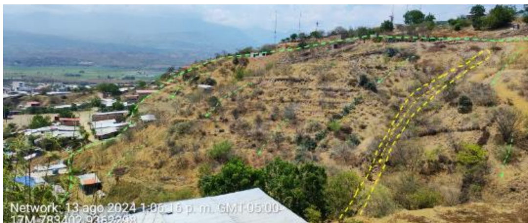
Figura 13. Parte alta del sector San Martín de Porres, donde se aprecia laderas afectadas por erosión en surcos (en verde) y erosión en cárcavas (en amarillo).
