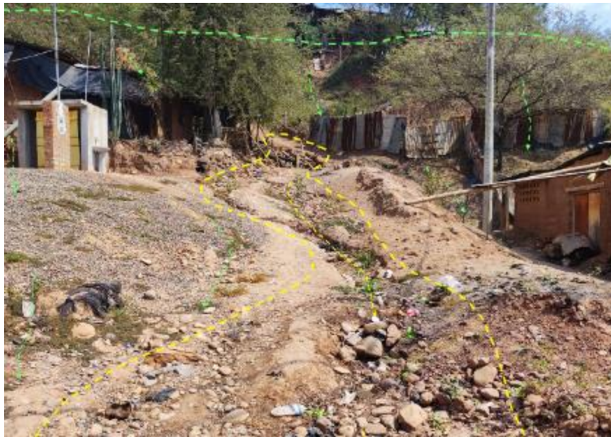
Figura 14. Erosión en cárcava (en amarillo) y en surcos (en verde) en el Jr. Junín del sector San Luis.
