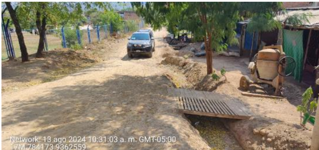
Fotografía 4. Quebrada que encausa flujos de detritos durante lluvias intensas y que cruza por una vía en el sector La Esperanza.
