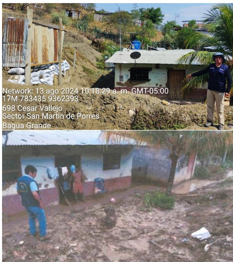
Figura 16. Vivienda que es afectada por flujos de detritos en el sector San Martín de Porres durante los trabajos de campo (arriba) y en febrero del 2024 (abajo). Fuente: Municipalidad Provincial de Utcubamba.
