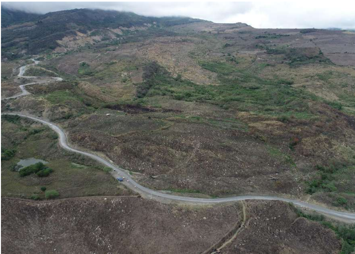
Fotografía 1. Vista de las subunidades geomorfológica mirando a la parte superior del deslizamiento Aserradero: relieve de montaña en roca sedimentaria (M-rs) y piedemonte coluvial (P-c). UTM: 812907 / 9345849, Zona 18.
