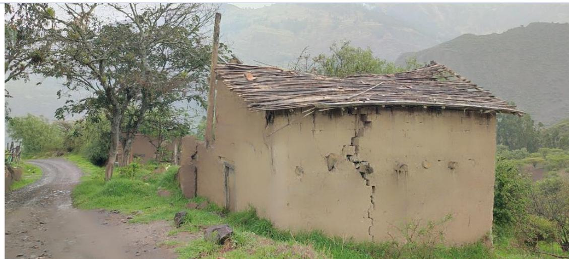
Viviendas destruidas por la activación de deslizamiento en 2015
