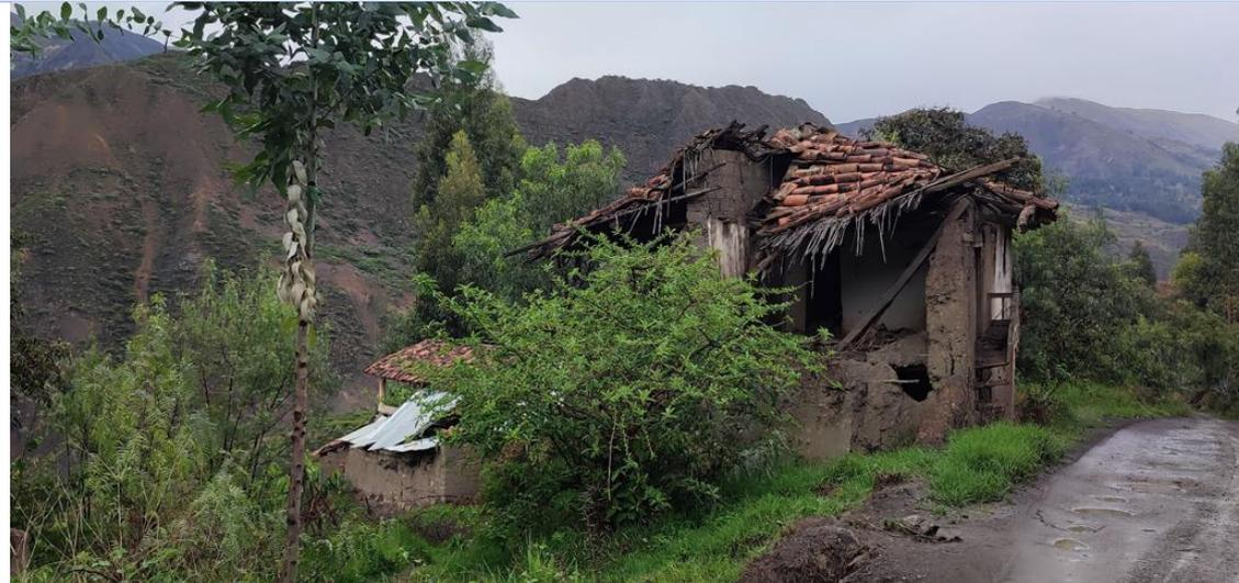
Viviendas destruidas por activación del deslizamiento en el 2015, cabe mencionar que siguen siendo ocupadas.
