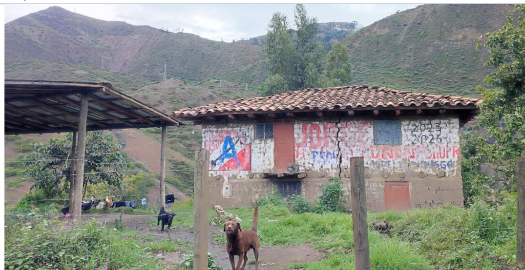
Vivienda que presenta rajaduras en el muro debido a los proceso de deslizamiento.
