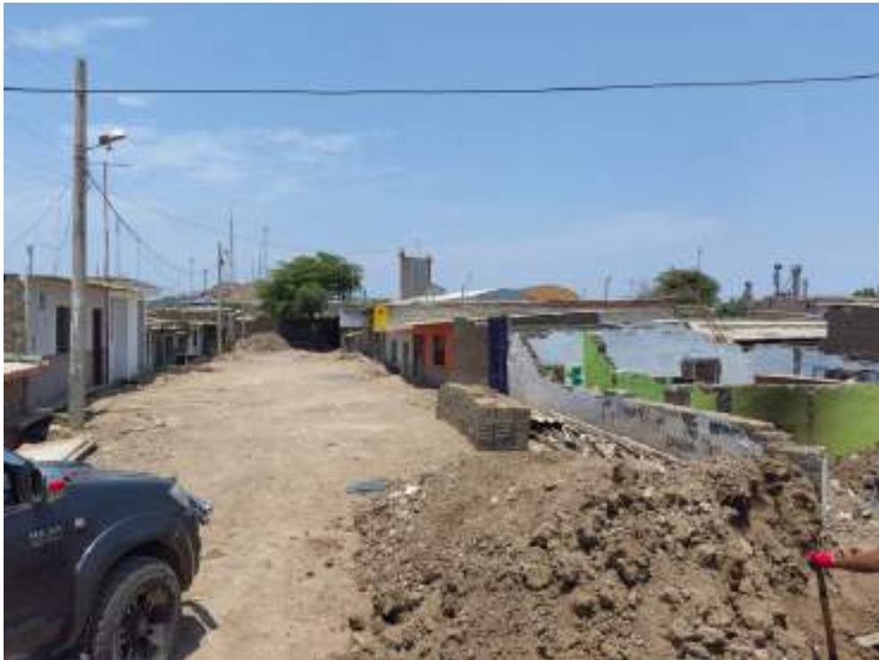
FOTOGRAFÍA 14: SECTOR LOS ARENALES, DEBIDO A SU CONDICIÓN DE VULNERABILIDAD TODO ESTE SECTOR ESTÁ EN PELIGRO.
