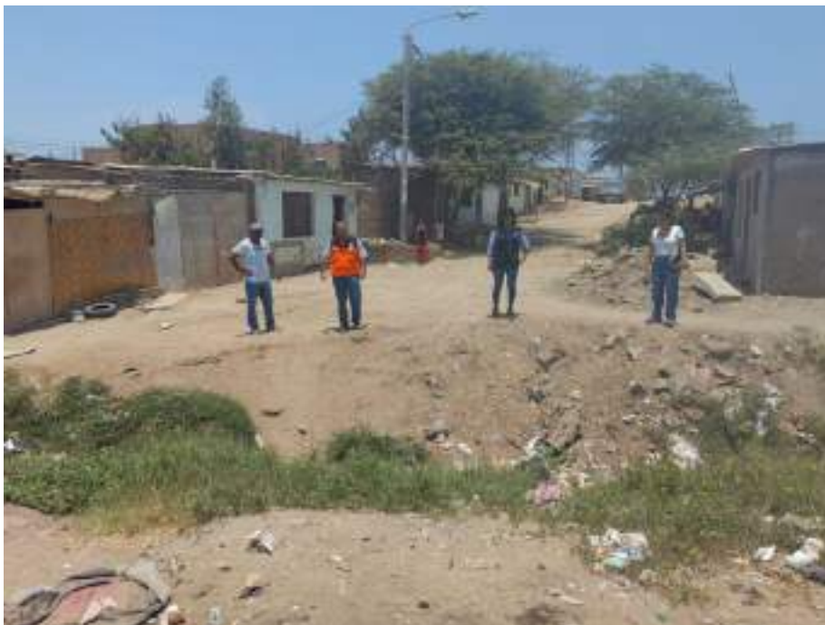
FOTOGRAFÍA 12: CANAL MENOR COLMATADO A 200 METROS DEL PUNTO MÁS BAJO DE ESTE SECTOR 13 DE ENERO.
