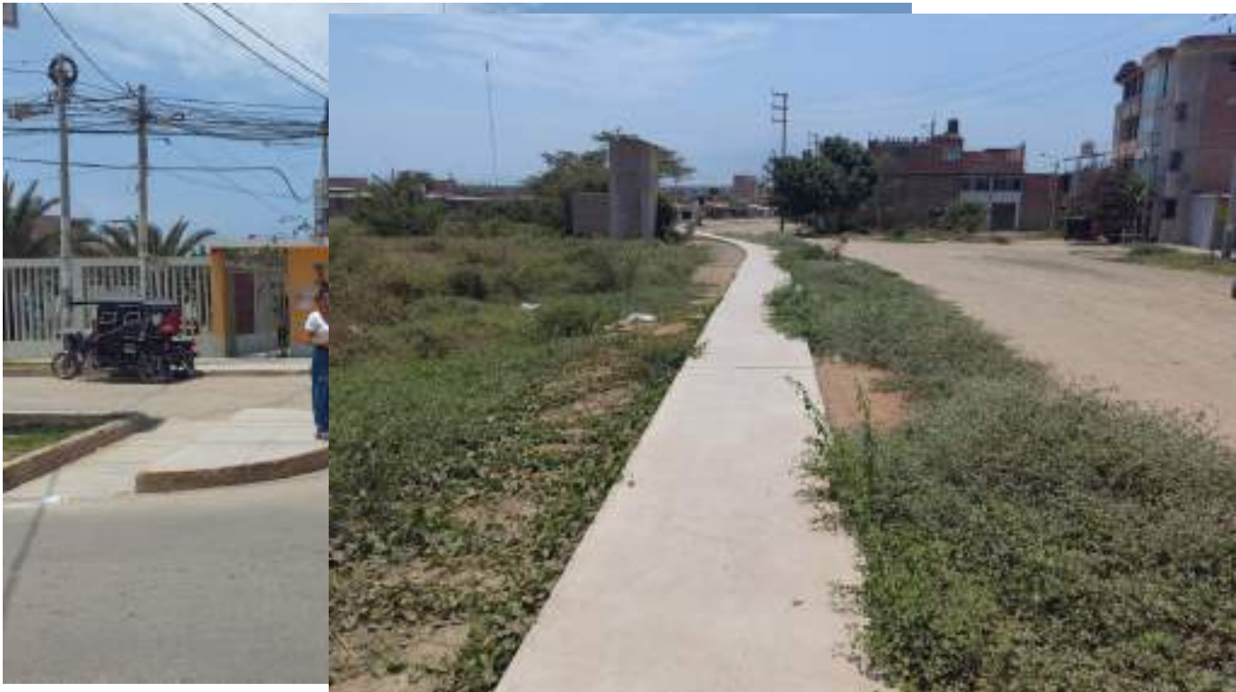
FOTOGRAFÍA 10: CANAL DE REGADÍO CON PLATAFORMA DE CONCRETO ALTURA DE URB. VILLA VERDE
