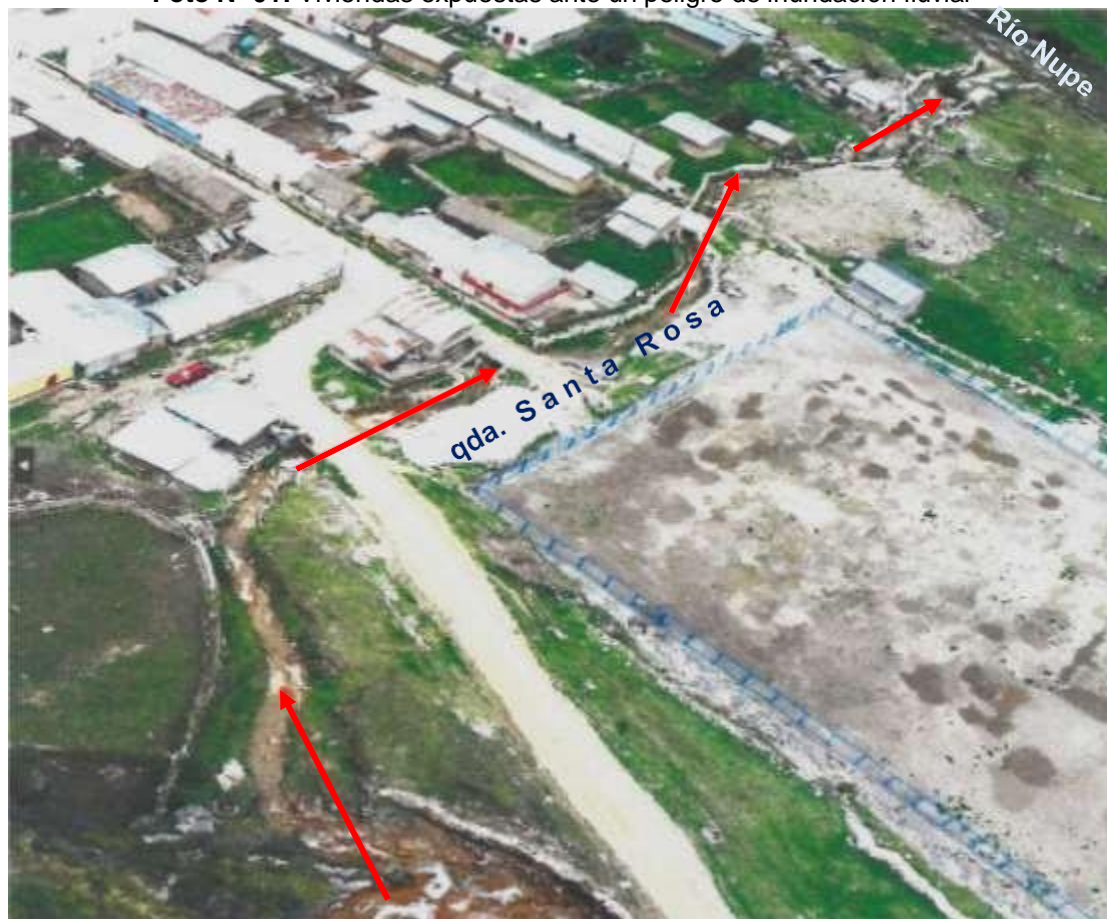
Foto N° 01: Viviendas expuestas ante un peligro de inundación fluvial
