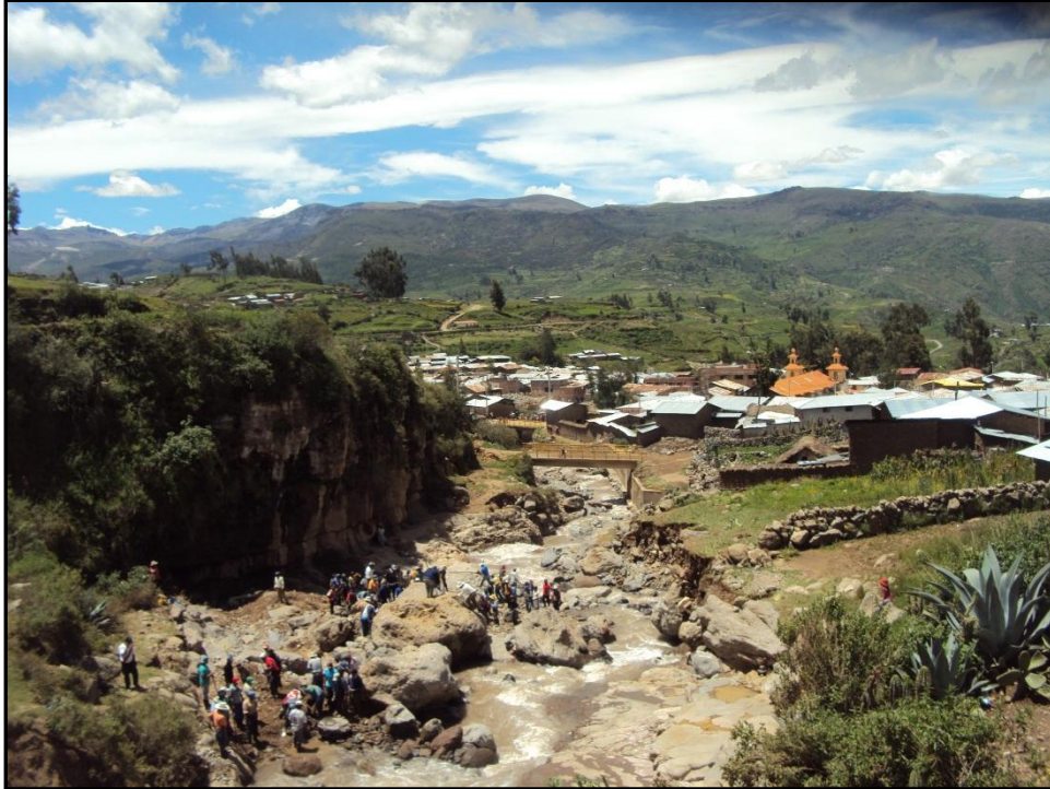
Ilustración N° 01 Vista General del Rio Calicanto y sus márgenes, se puede apreciar el trabajo de los pobladores para encauzar el río.
