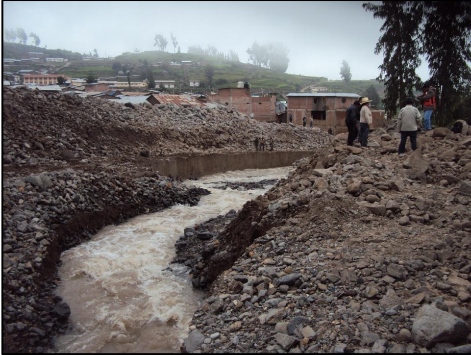
Lustración N° 5: Área afectada por el huayco
