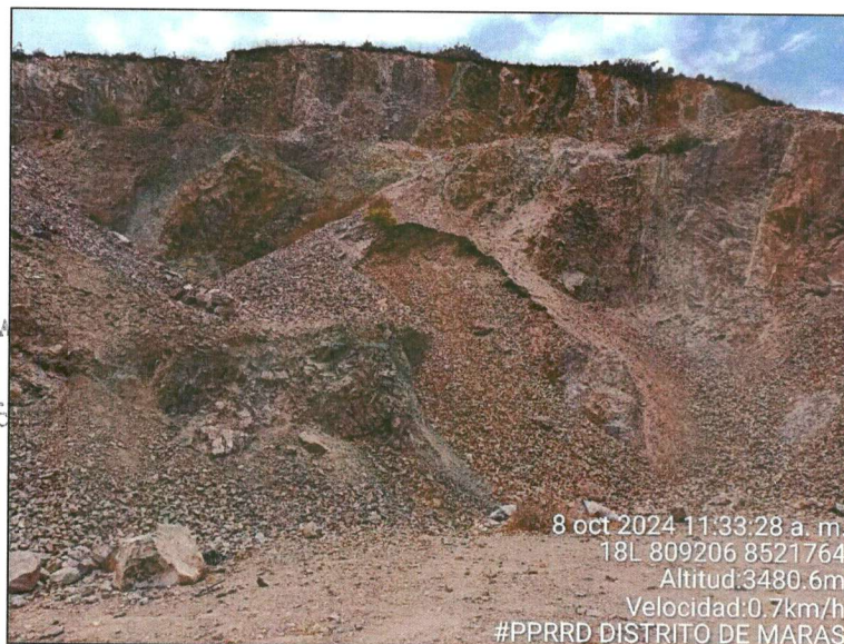
FOTOGRAFÍA 3. VISTA FORMACIÓN KAYRA, USADA COMO CANTERA.
