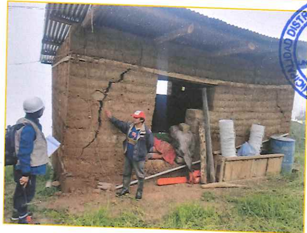
Inspección técnica de puntos críticos en el Anexo Huanchay
