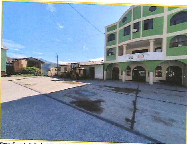
Vista frontal de la Municipalidad Distrital de San Miguel de Corpanqui.
