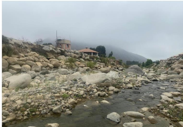
FIGURA N° 01: TRAMO CRÍTICO EN EL RÍO LA CUESTA, EN EL SECTOR PEDREGAL-BADEN, DISTRITO DE SIMBAL, PROVINCIA DE TRUJILLO, DEPARTAMENTO DE LA LIBERTAD.
