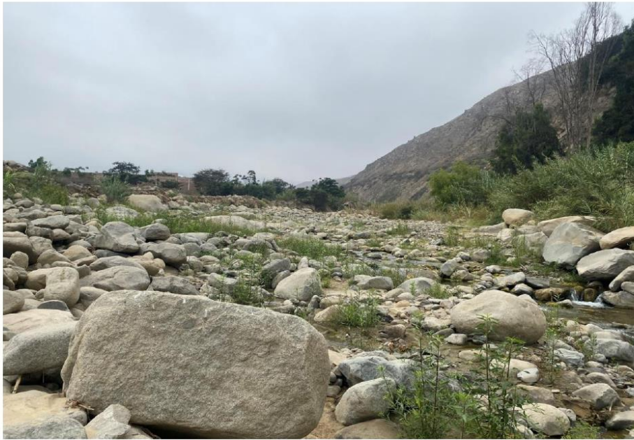
FIGURA N° 03: EN LA TEMPORADA DE MAXIMAS AVENIDAS, EL RÍO LA CUESTA SE DESBORDA EN ESTE TRAMO DEL SECTOR
