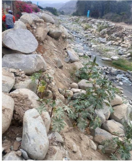
FIGURA N° 02: SECTOR DEL CAUCE CON PRESENCIA DE ROCAS SEDIMENTADAS PRODUCTO DE HUAYCOS EN EL RIO LA CUESTA
