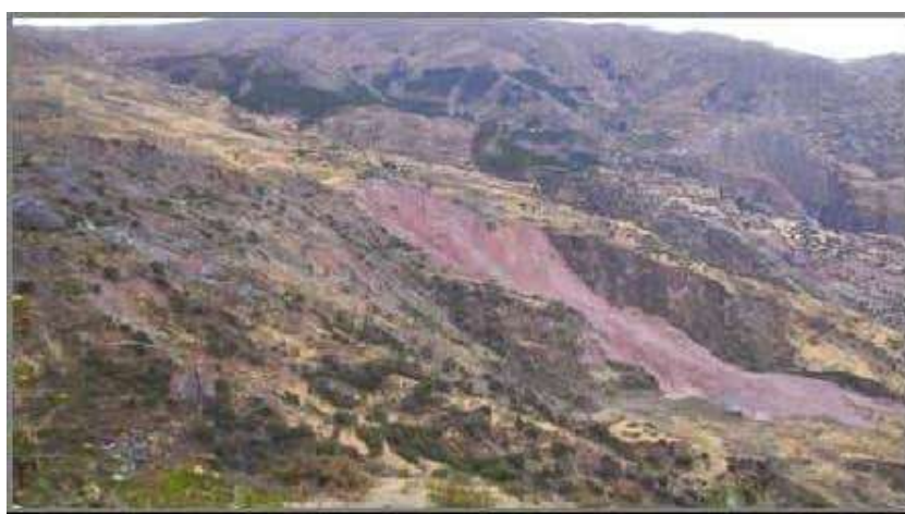
Formación Maras con presencia de material deleznable. Distrito de Rondocan. Fuente: Gobierno Regional Cusco, FOT/ÁREA DE GEOLOGÍA, 2009.
