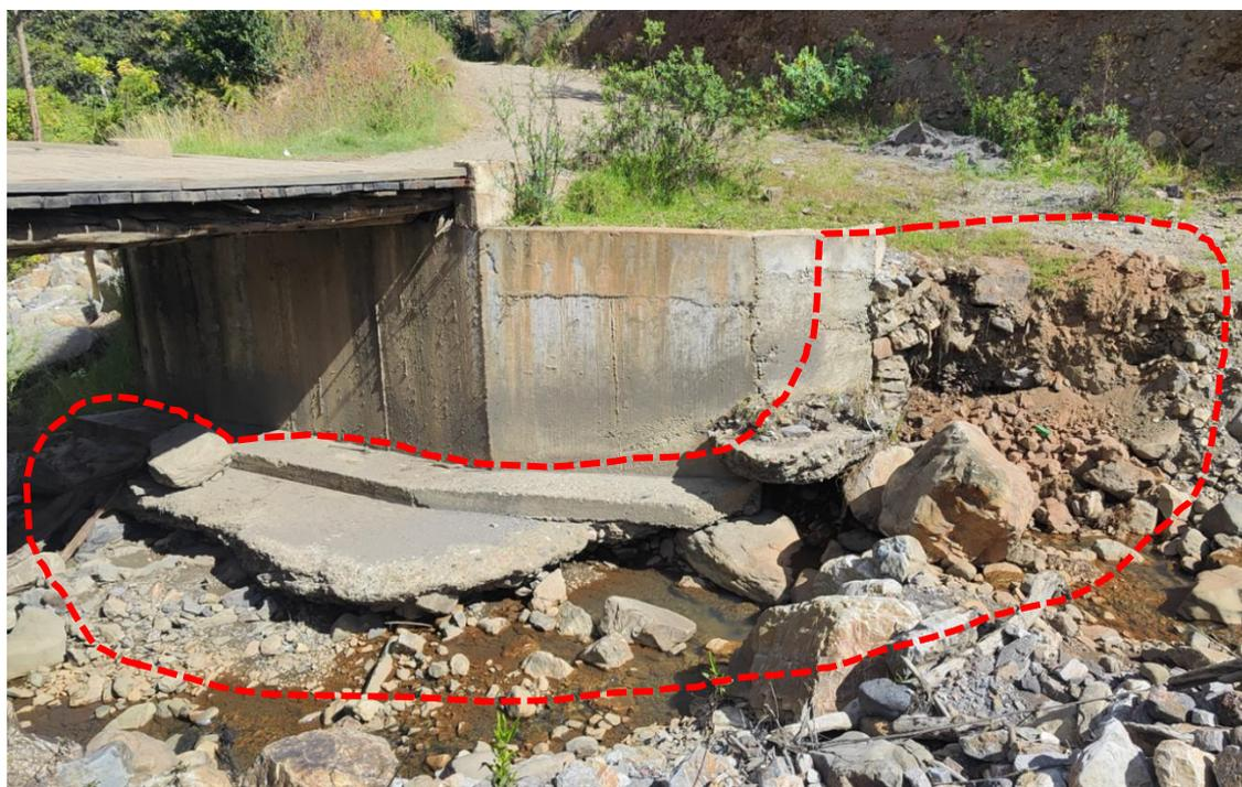
Socavamiento y exposición del estribo del puente y erosión lateral
