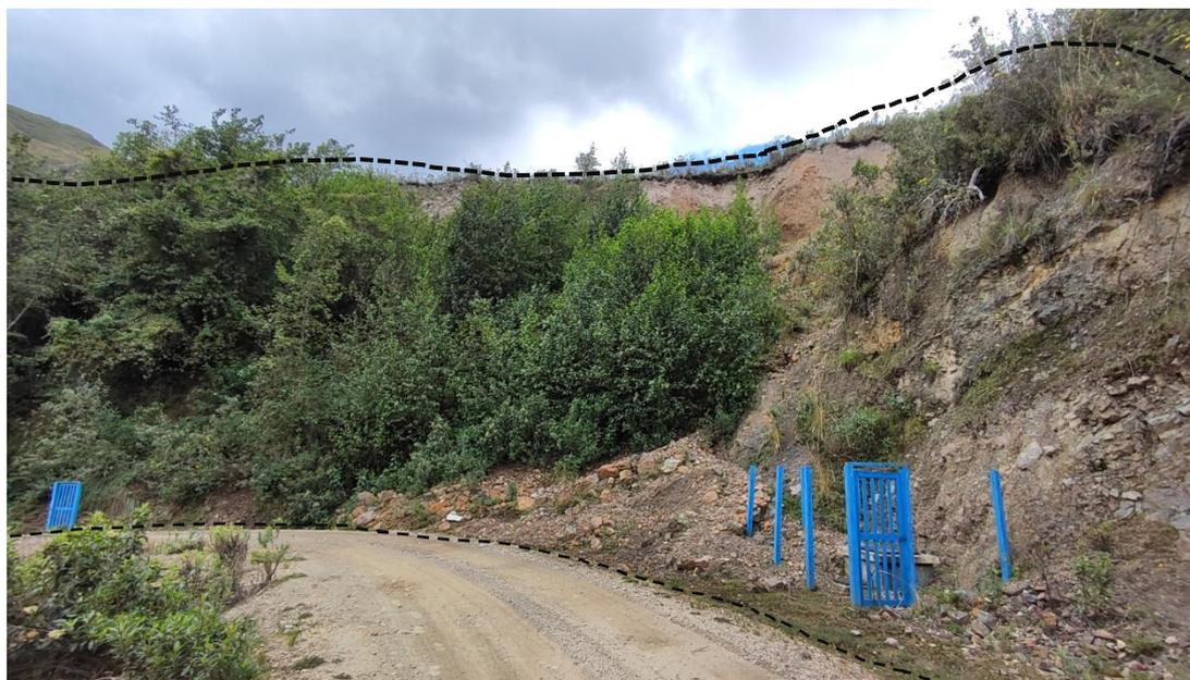
Se observa deslizamiento que ha sepultado parte del cerco de la captación y la cámara rompe presión.
