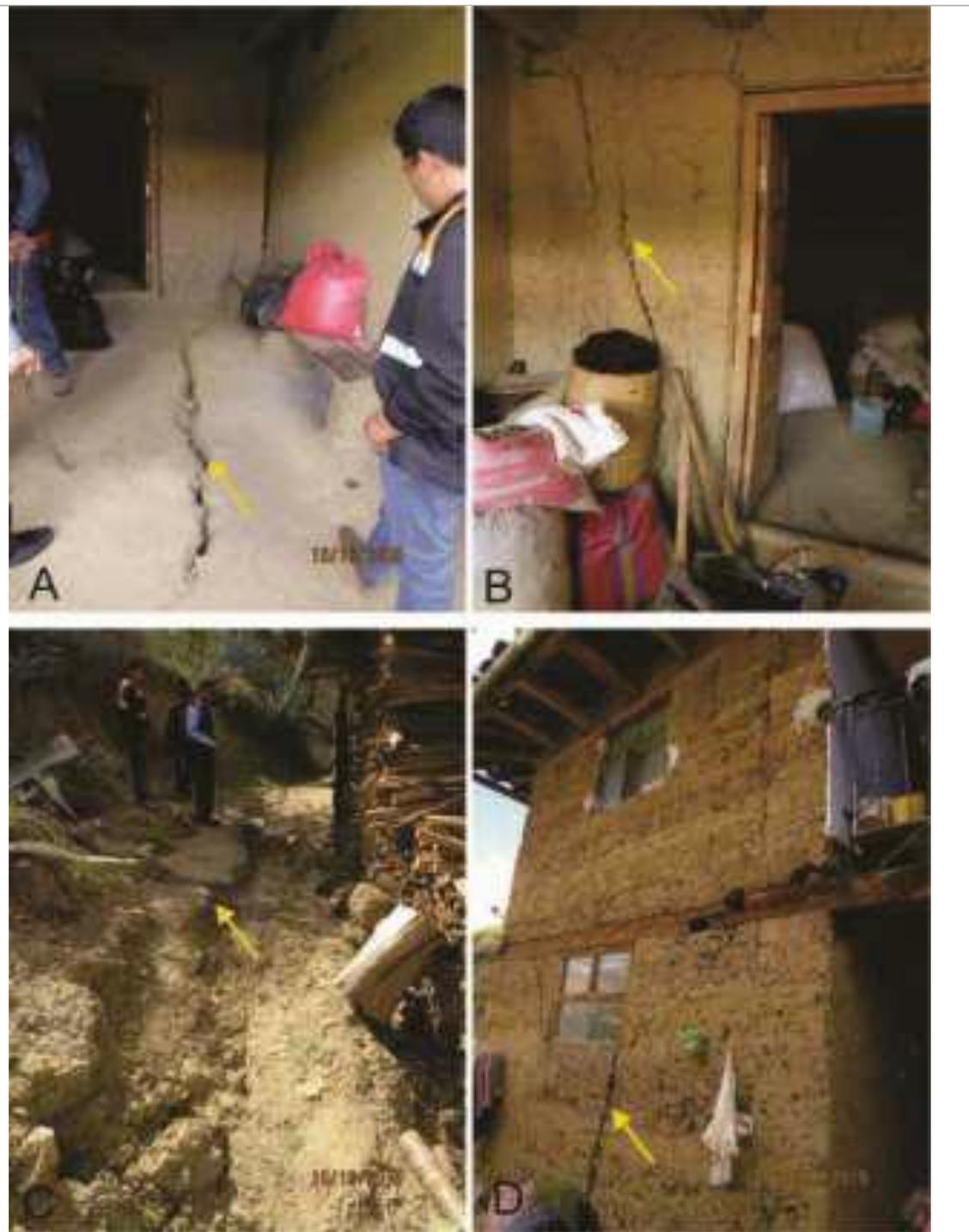
Vivienda ubicada en la coordenada UTM: 232606 E - 9020296 N presenta grietas en las paredes y piso (A, B y D), también se observa grieta en el talud superior donde se ubica la vivienda (C).
