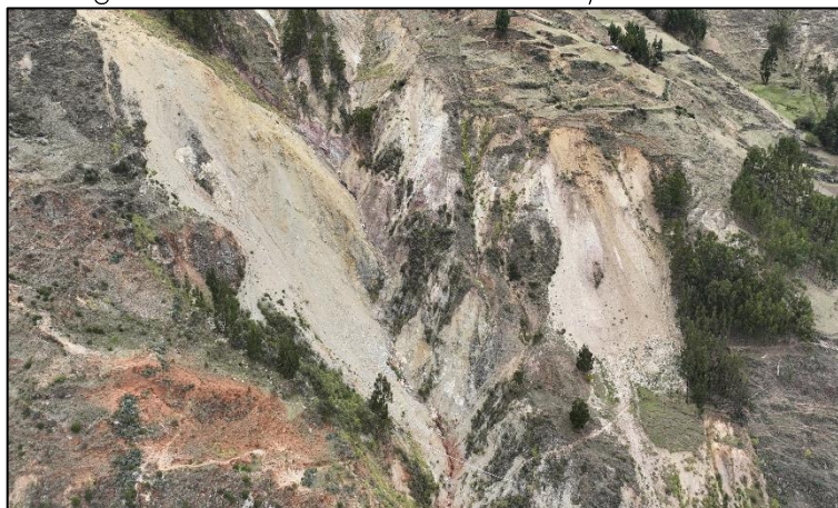
Imagen N° 11. Vertiente de Deslizamiento y caída de rocas.
