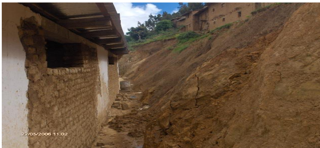
ILUSTRACIÓN 13. MOVIMIENTO DE MASAS – DERRUMBE - INKAWASI
