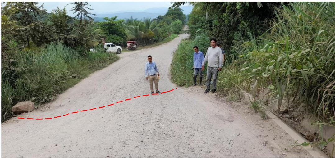
**Foto N° 06.** En colindancia con la quebrada de Zapaterillo, se tiene estas fisuras un poco profundas siendo en su mayoría compuestas de areniscas y gravas (coluivialuvial)
