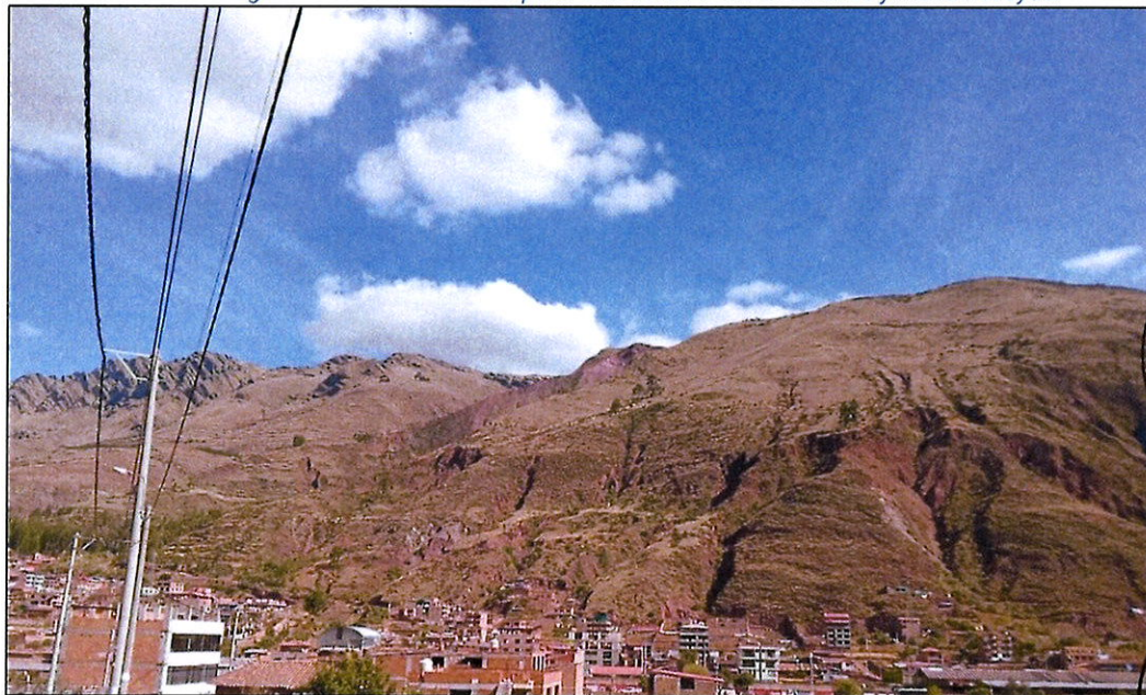
Fotografía 25: Cárcavas en la parte alta de la APV. Ferroviarios y Mollemolleyuc.
