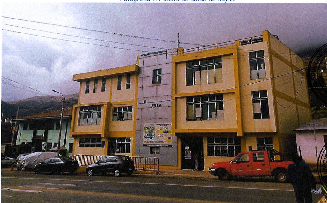
Fotografía 1: Puesto de salud de Saylla
