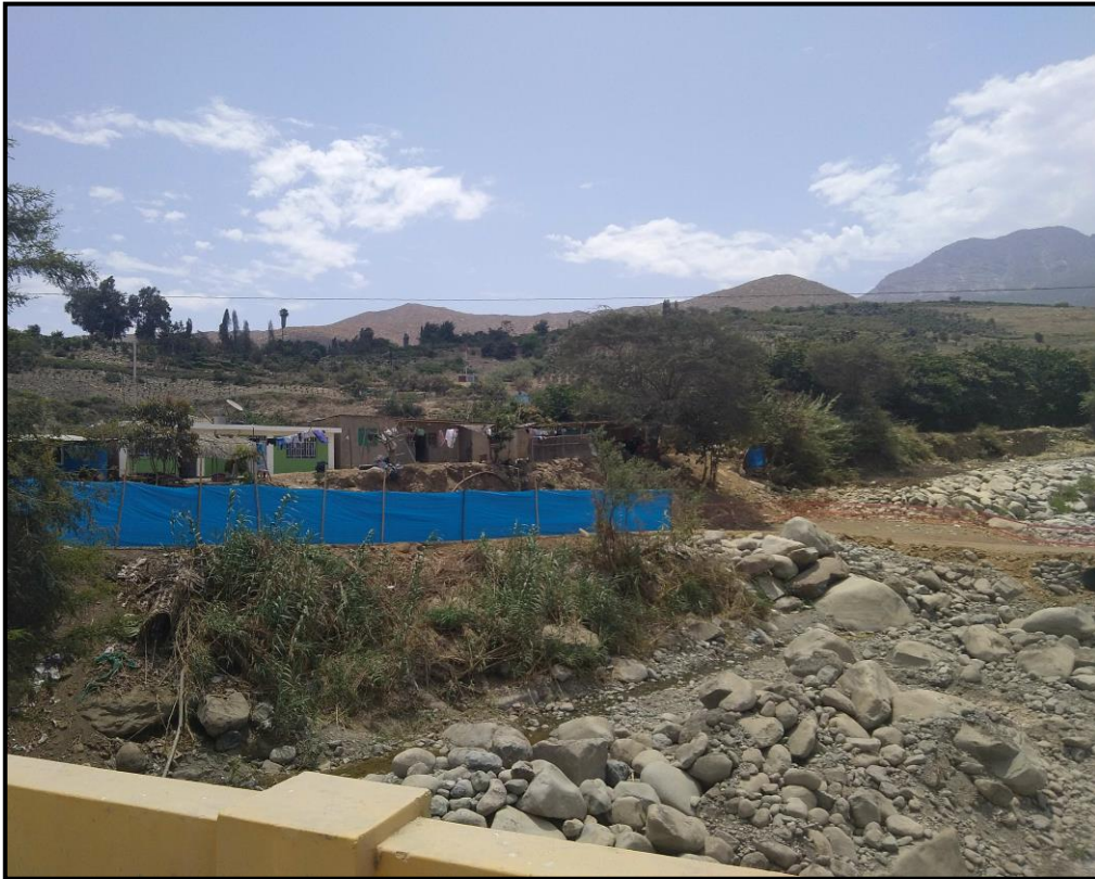
Fotografia21. Viviendas del centro poblado Huamba Baja ubicadas a 2m aprox del cauce del río Huarmey. Se ven afectadas por la erosión fluvial que provoca el socavamiento de las laderas - HH-011-I
