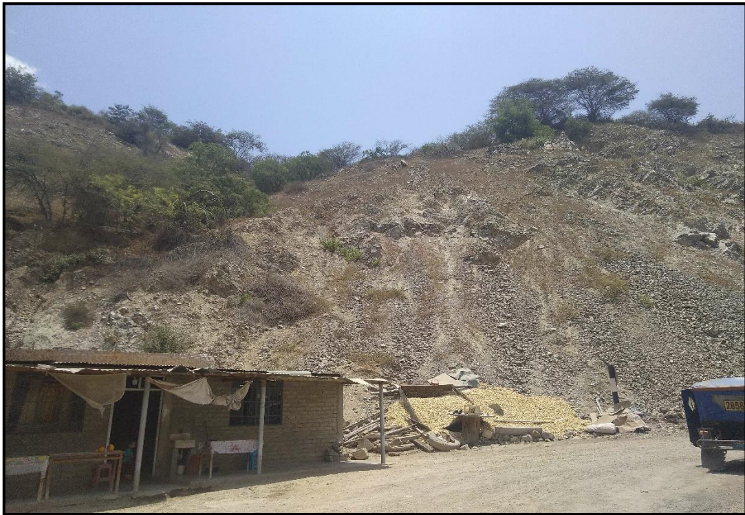
Fotografia27. Vivienda expuesta ante el peligro por de flujo de detritos por la activación de la quebrada en el centro poblado Huamba Baja - HH-010-M
