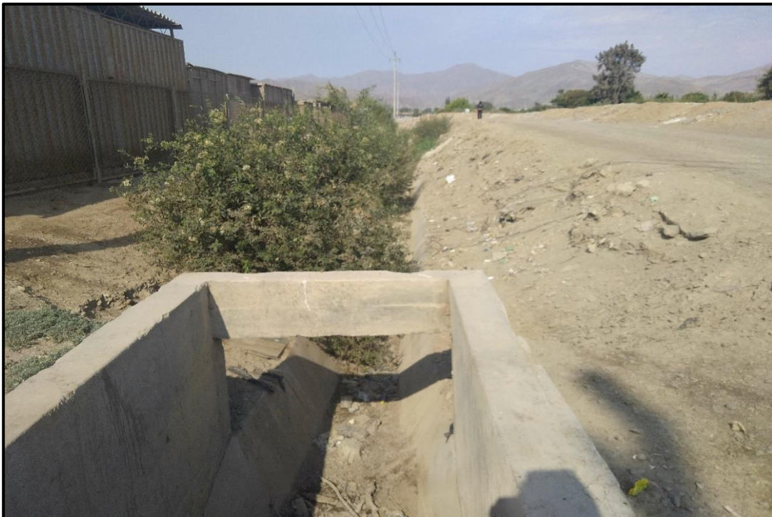
Fotografia16. Canal de regadío en desuso ubicado en paralelo a la dirección del flujo del río Huarmey. Se activa y desborda por las lluvias intensas en la ocurrencia de eventos anómalos como “El Niño”
