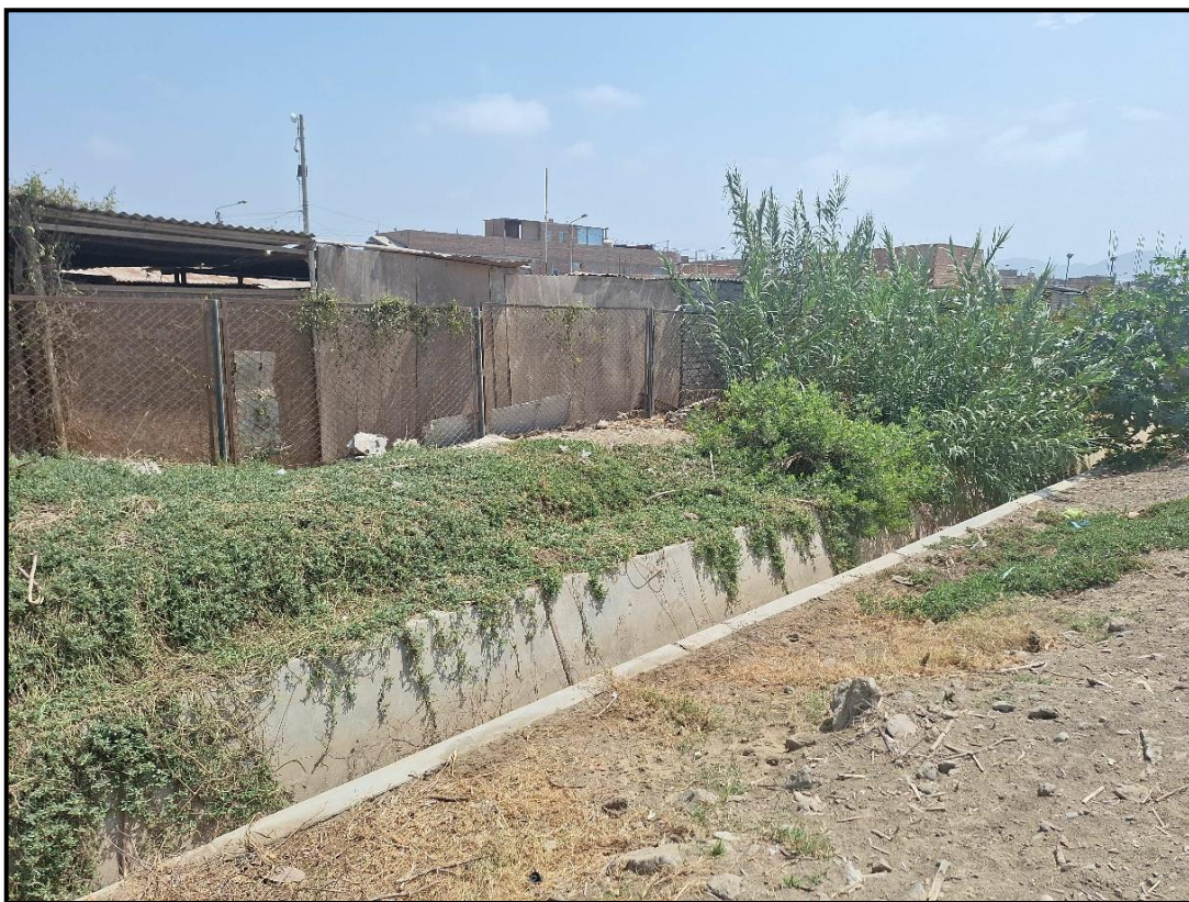
Fotografia17. Viviendas expuestas al peligro por inundación por el desborde del canal y del río Huarmey - Zona crítica - HH-004-I
