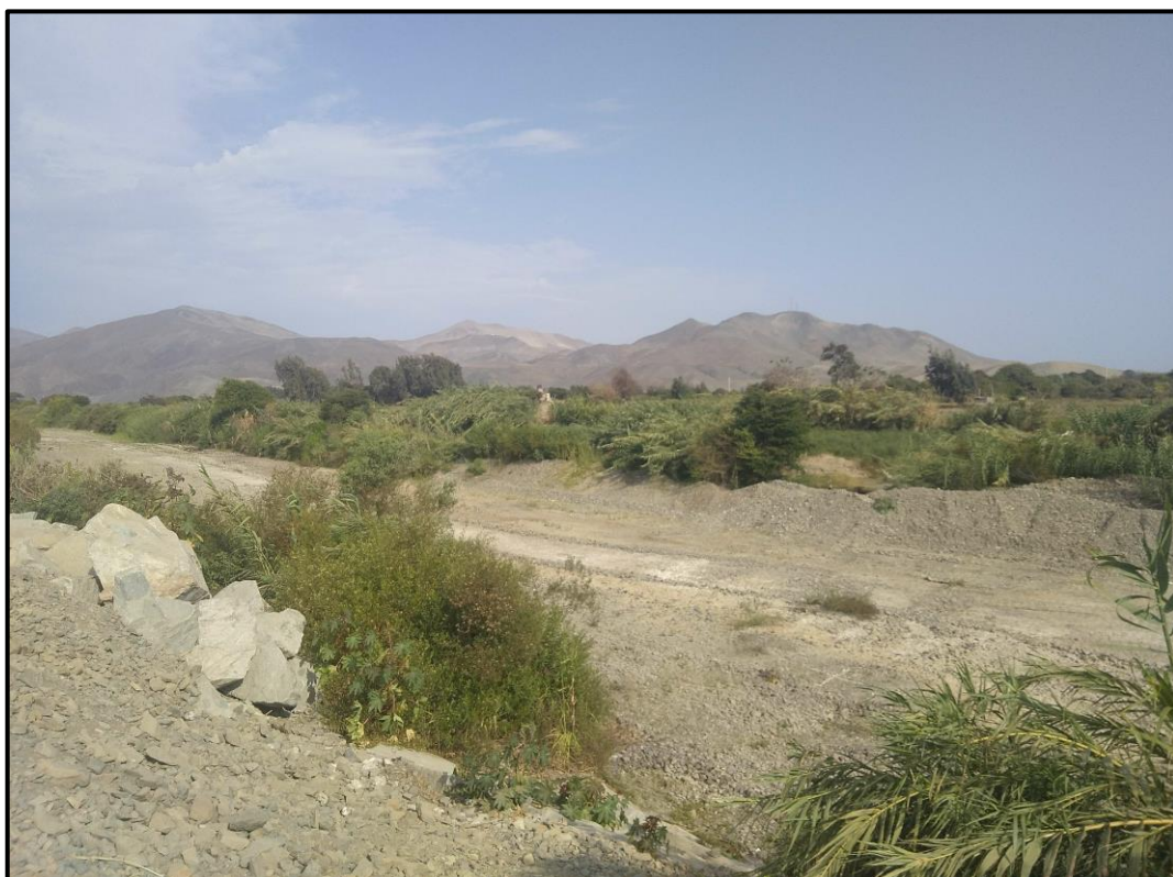
Fotografia18. Vista del cauce del río Huarmey. Tramo donde se desborda el río Huarmey a consecuencia de las lluvias anómalas positivas en la ocurrencia de eventos anómalas Zona crítica - HH-005-I
