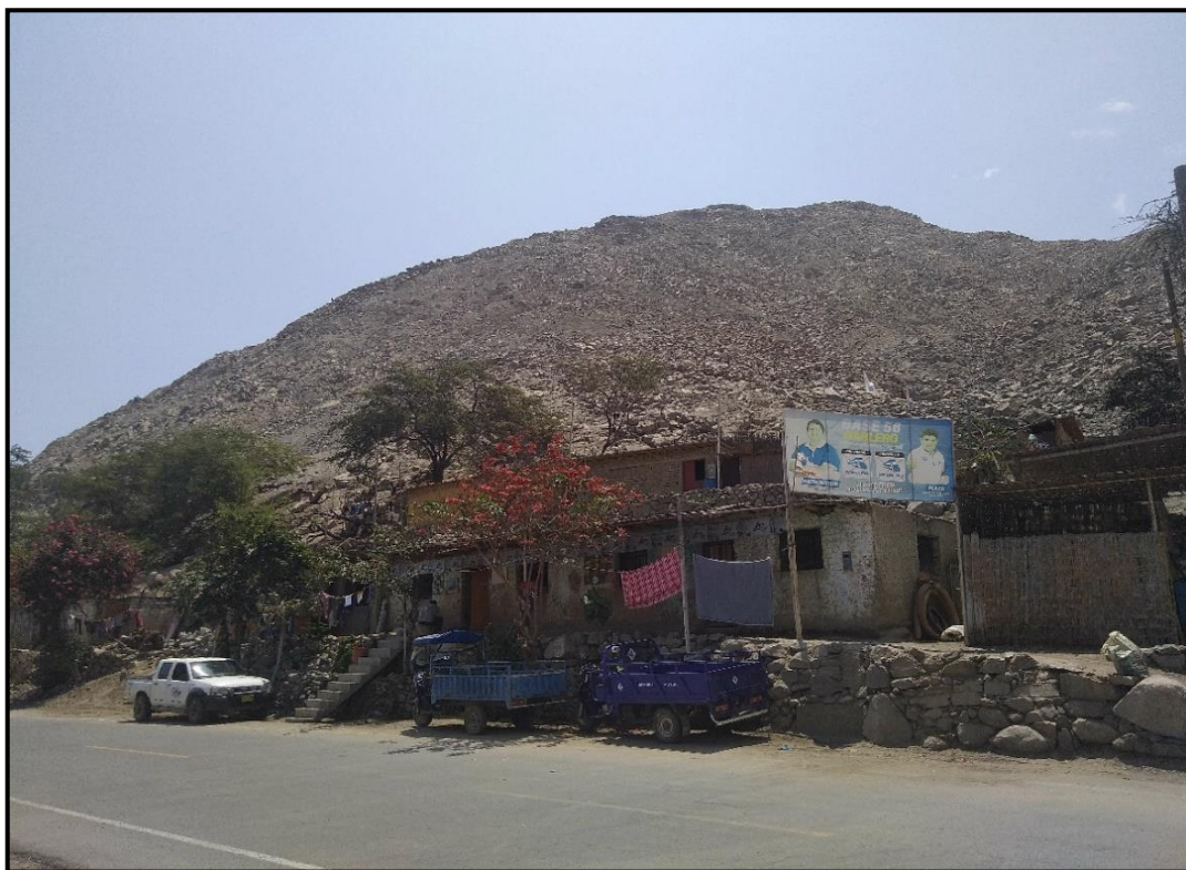
Fotografia25. Viviendas expuestas ante el peligro por de flujo de detritos por la activación de la quebrada en el centro poblado Garlero – HH-008-M
