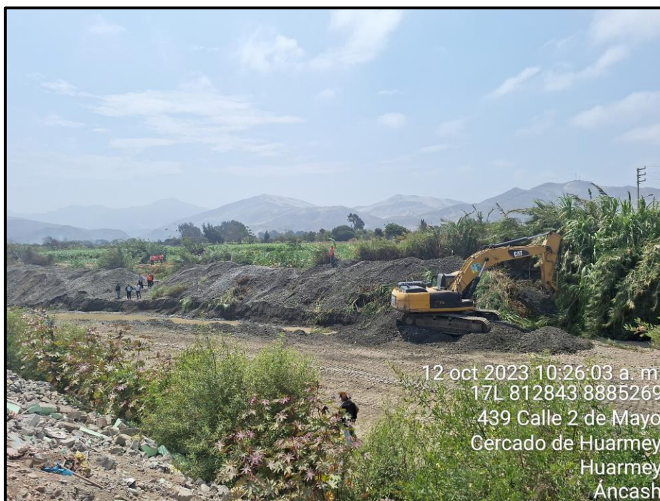
Fotografia54. Labores de limpieza y descolmatación del cauce del río Huarmey por parte del ANA
