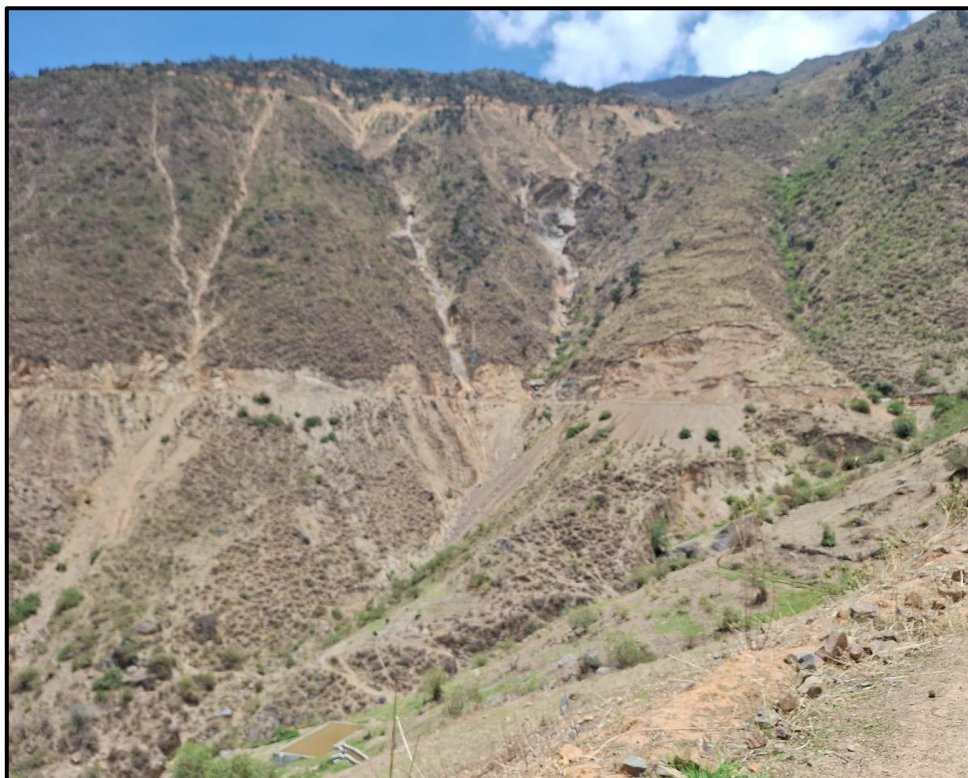
Fotografia53. Vista de la quebrada con antecedentes de activación por la presencia de lluvias anómalas positivas en el centro poblado Huichay Zona crítica – HCO-001-M
