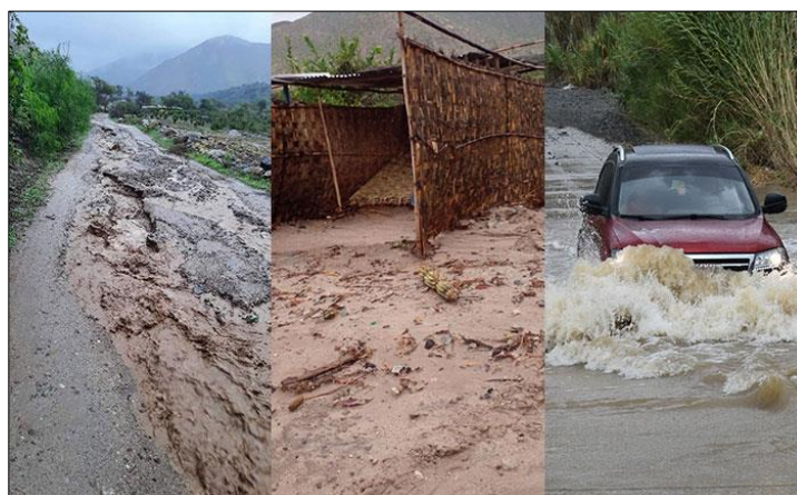
Figura 9. Viviendas y vías de comunicación afectadas
