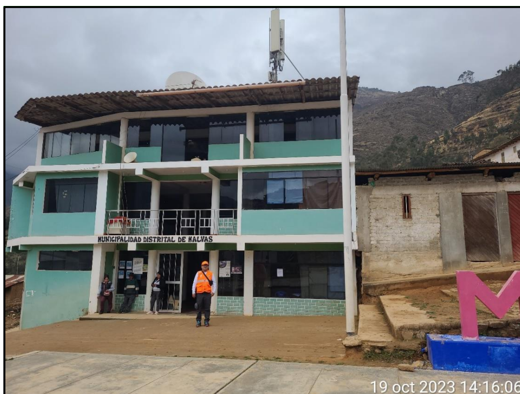
Fotografia46. Vista frontal de la Municipalidad Distrital de Malvas
