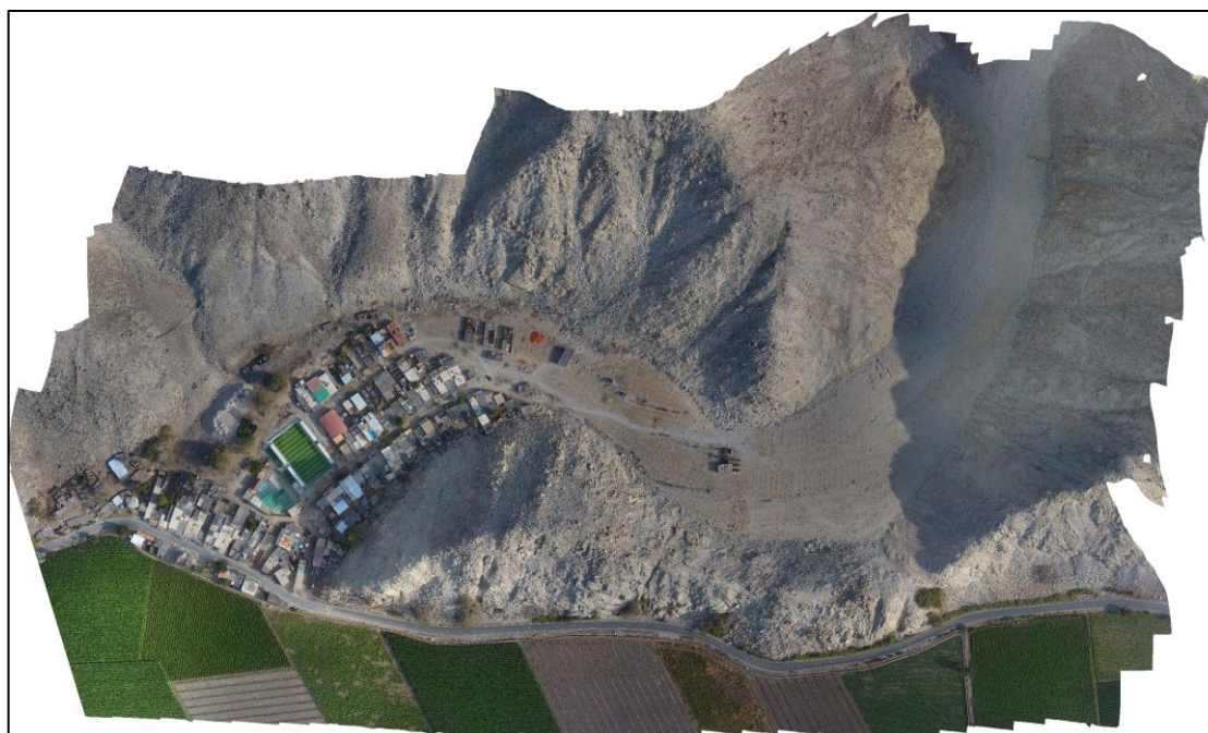
Fotografia62. Vuelo fotogramétrico en la zona crítica por flujo de detritos en el C.P. Garlero – Distrito Huarmey
