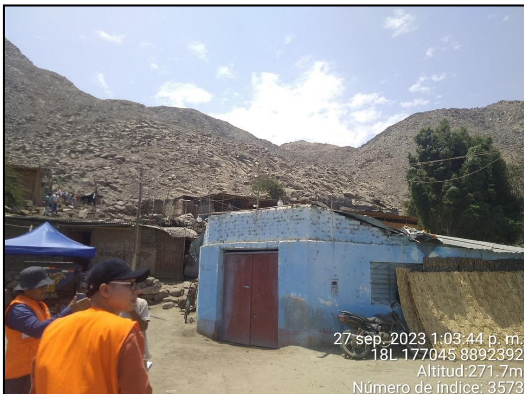
Fotografía24. Viviendas expuestas ante el peligro por de flujo de detritos por la activación de la quebrada en el centro poblado Garlero - Zona crítica – HH-008-M
