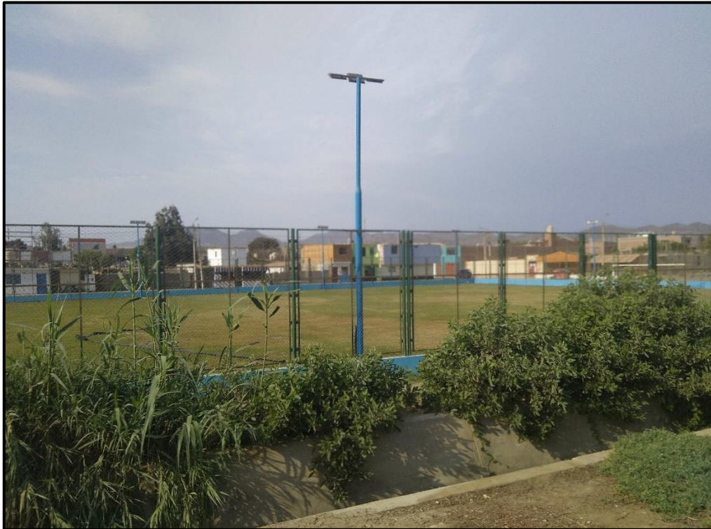
Fotografia15. Campo deportivo expuesto por peligro de inundación por el desborde del río Huarmey a consecuencia de las lluvias anómalas positivas frente a la ocurrencia de eventos anómalos - Zona crítica - HH-004-I
