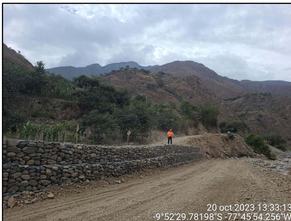
Fotografia55. Trabajos de defensas ribereñas – Gaviones (enrocado con enmallado metálico)
