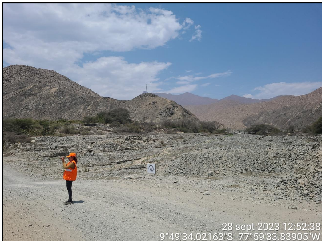
Fotografia36. Trocha carrozable expuesta ante el peligro por flujo de detritos por la activación de la quebrada en el centro poblado Lagunas - Zona crítica – HCU – 008 M
