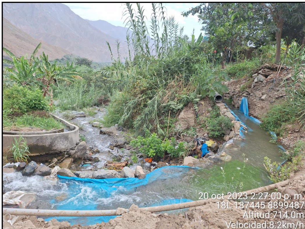
Fotografia22. Canal de regadío que cruza una quebrada Zona crítica - HH-012-I
