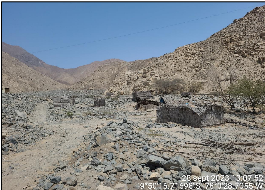
Fotografia35. Peligro por flujo de detritos ante la activación de la quebrada en el centro poblado Cusmo
