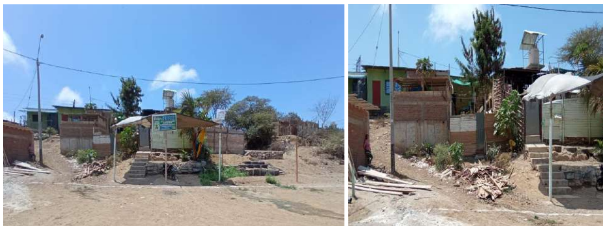
Figura A5. Parte posterior de viviendas de la manzana E', sector Trujillo IV. Se aprecia que las viviendas no estarían cumpliendo los linderos establecidos en el plano catastral.
