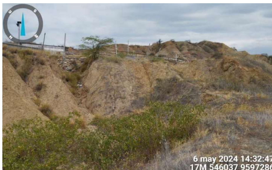
Figura N° 17. Cárcavas que afectan principalmente laderas, debido al suelo muy susceptible a erosión, vista en la parte alta de la quebrada Trujillo.
