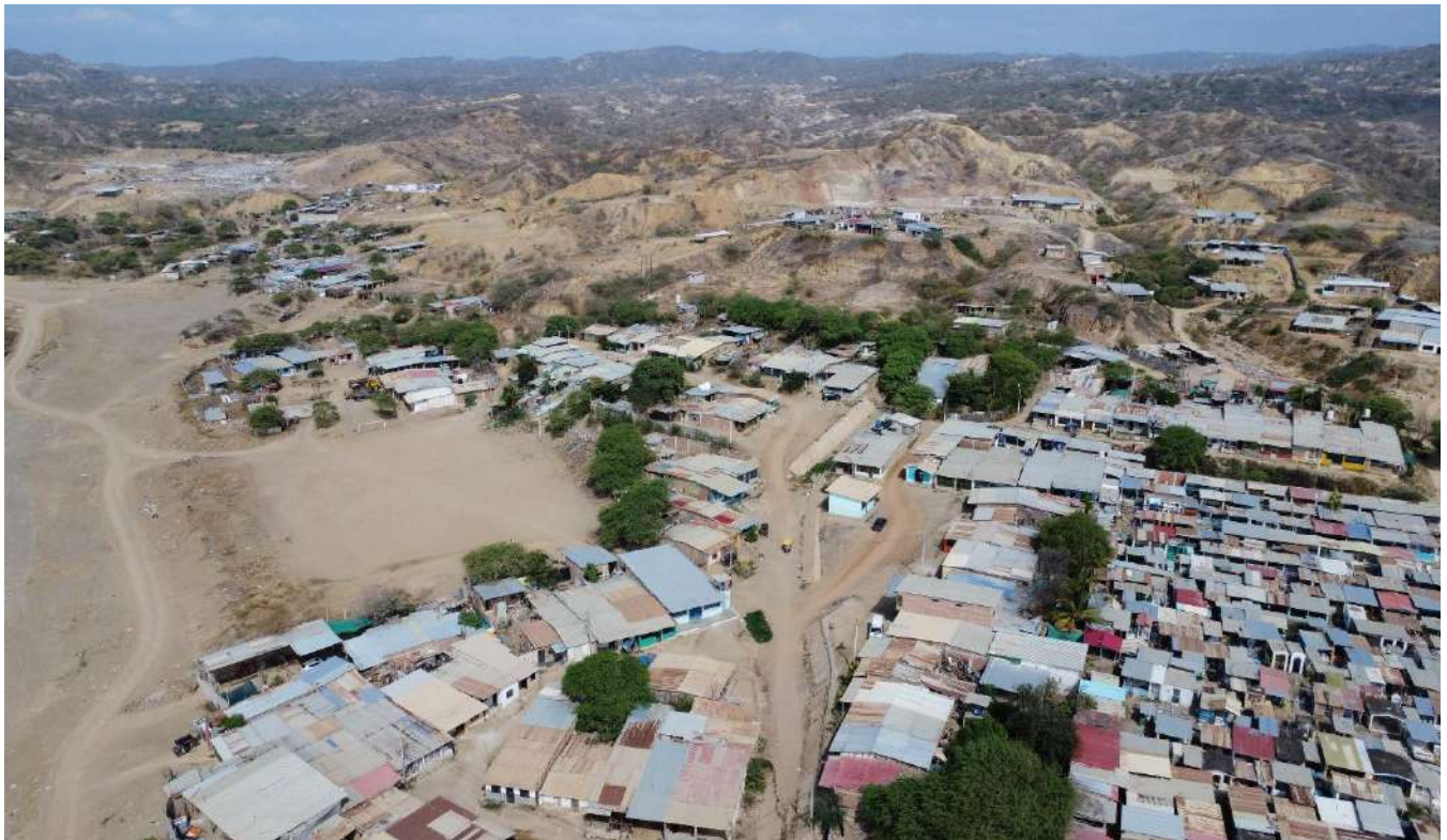
Figura A8. Vista aérea del Sector Trujillo IV, manzanas B', E, E', D, C, I y G, ortofoto tomada con Dron DJI.
