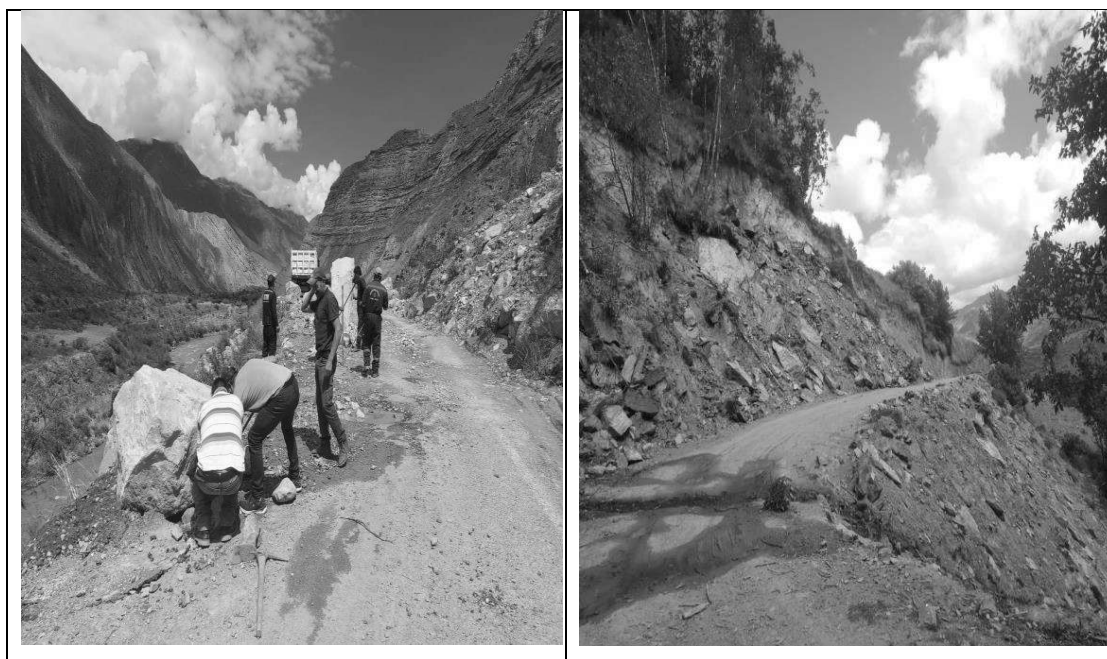
Ilustración 11: Deslizamiento en el tramo de Huacaybamba a Pinra (Caján)
