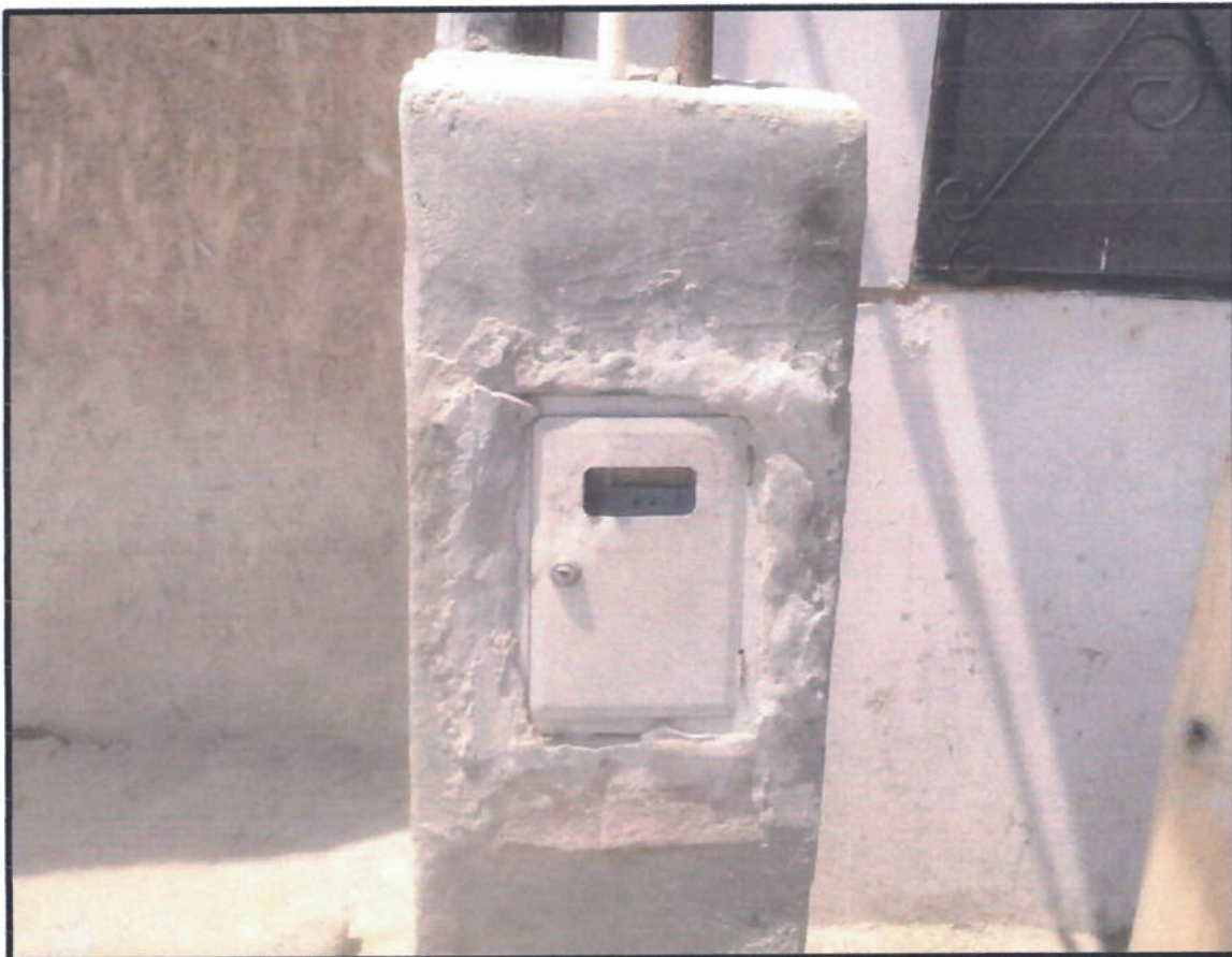
Foto 6 Vista del medidor de energía eléctrica
