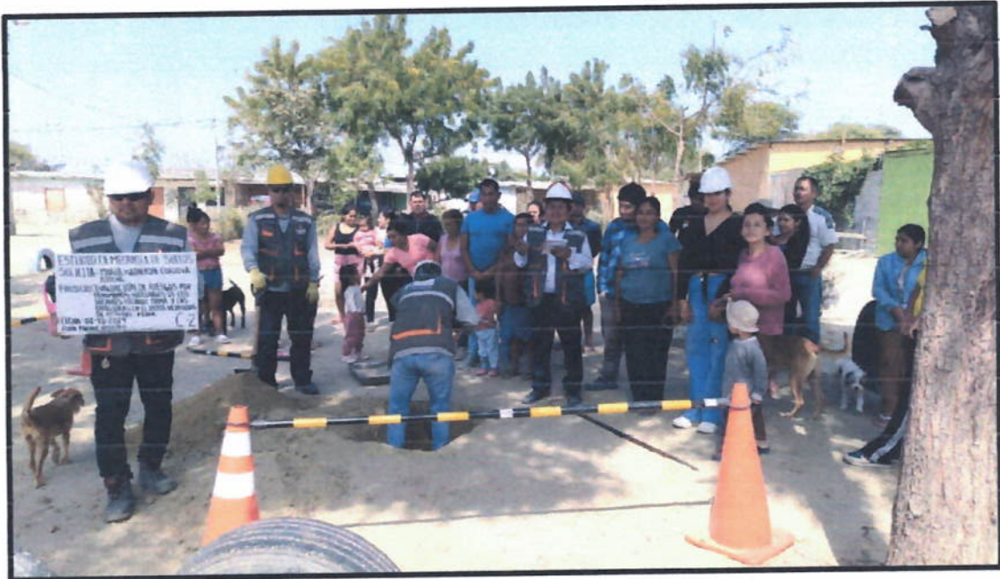
Foto 9 Trabajo de Campo para la Elaboración del Estudio de Mecánica de Suelos
