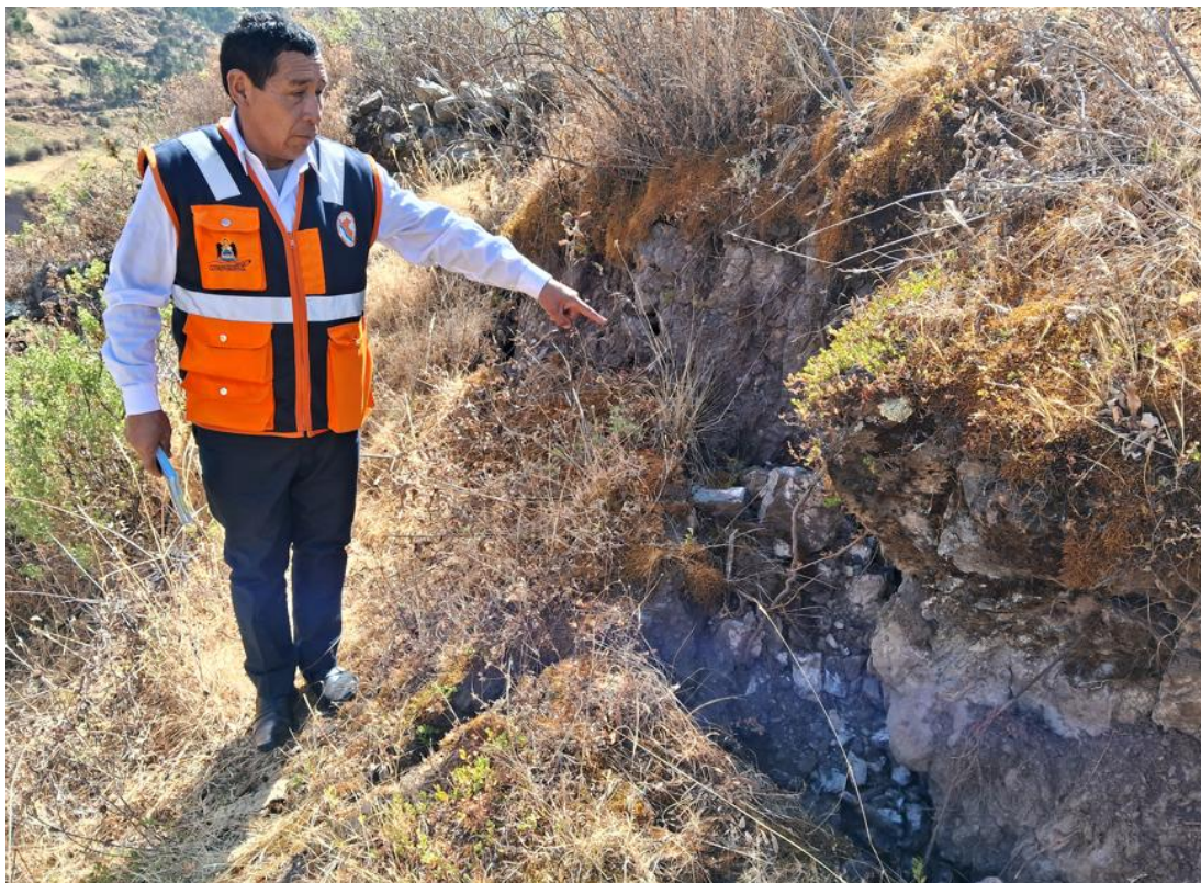
Fotografía 3. Muestra parte del escarpe principal del deslizamiento rotacional activo 2 (Dr-a2)
