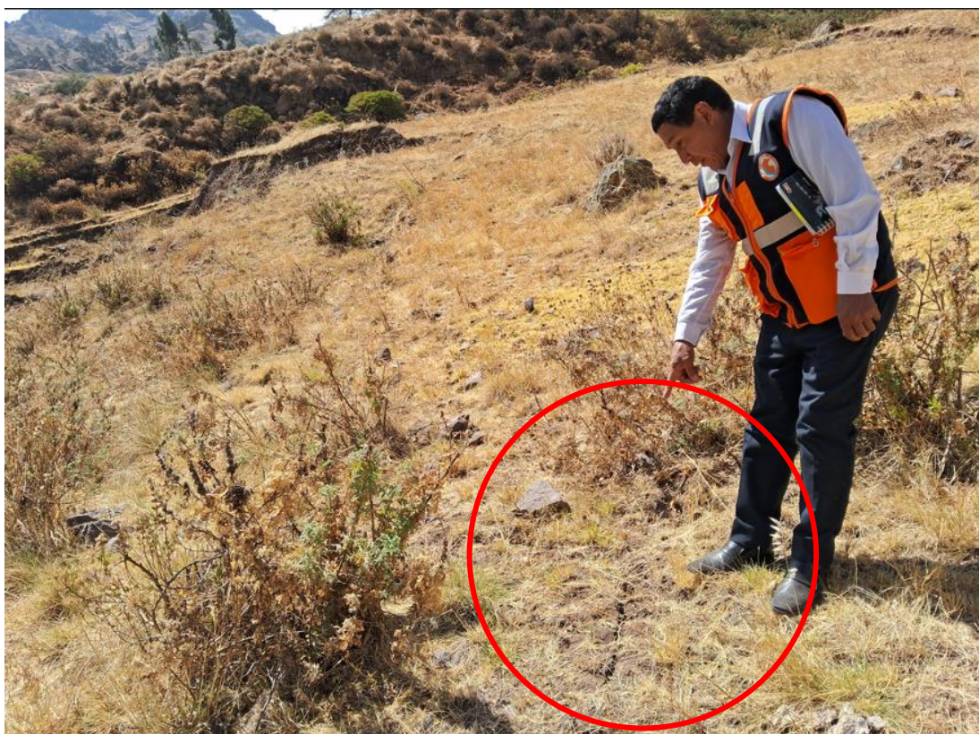
Figura 19. Agrietamientos de 4 cm de apertura, paralelos y anteriores a la corona del deslizamiento rotacional activo 2
