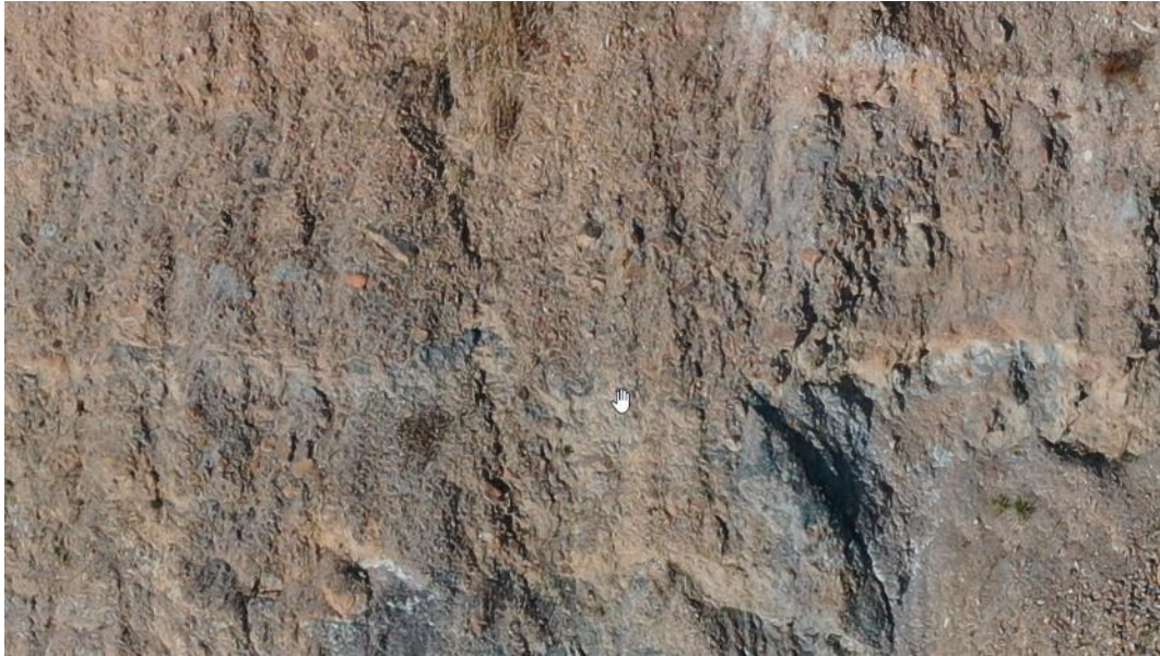
Fotografía 1. Lutitas grises y areniscas de grano medio color rojizo, muy fracturadas y moderadamente meteorizadas, coordenadas UTM WGS84 17M. 800495, 9132439
