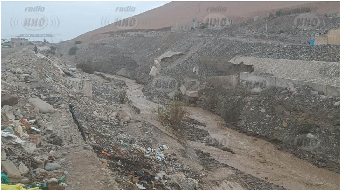
**Activación del Cauce Río Seco - Arunta, algunos muros de contención cedieron**
