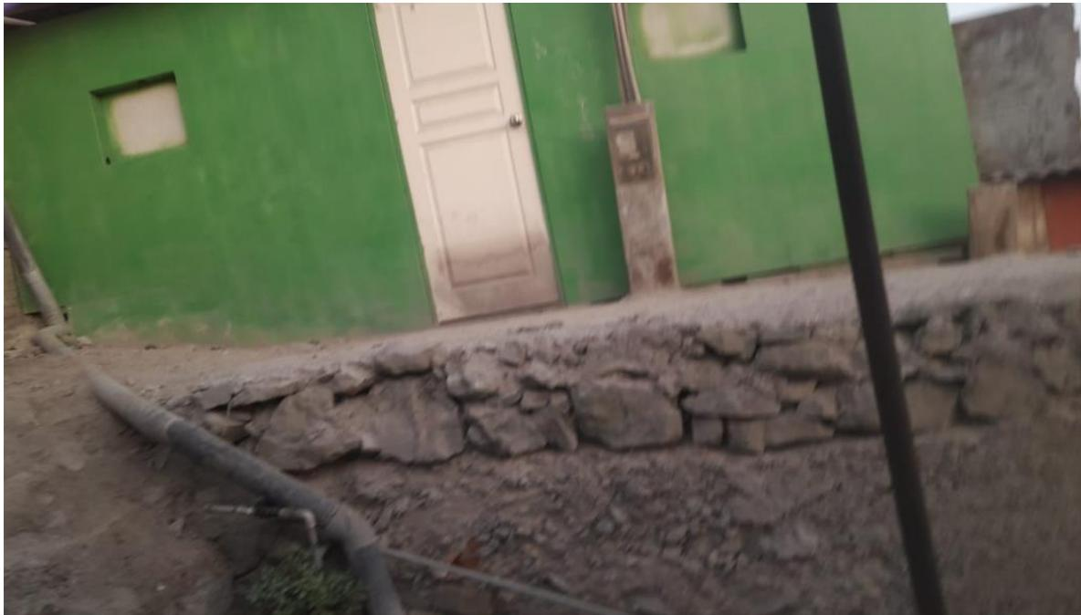
La ausencia de presencia de muro de contención en taludes inestables y sin barandillas perimétricas de seguridad
